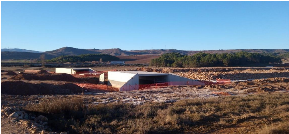
Ejecución de drenajes (Drenaje transversal y manto drenante en ejecución en Conexión 1).
