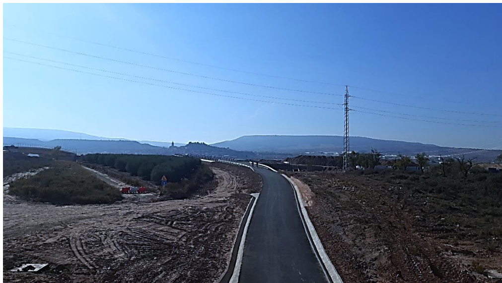
Reposición del Camino de Santiago sobre A-68 en Navarre.
