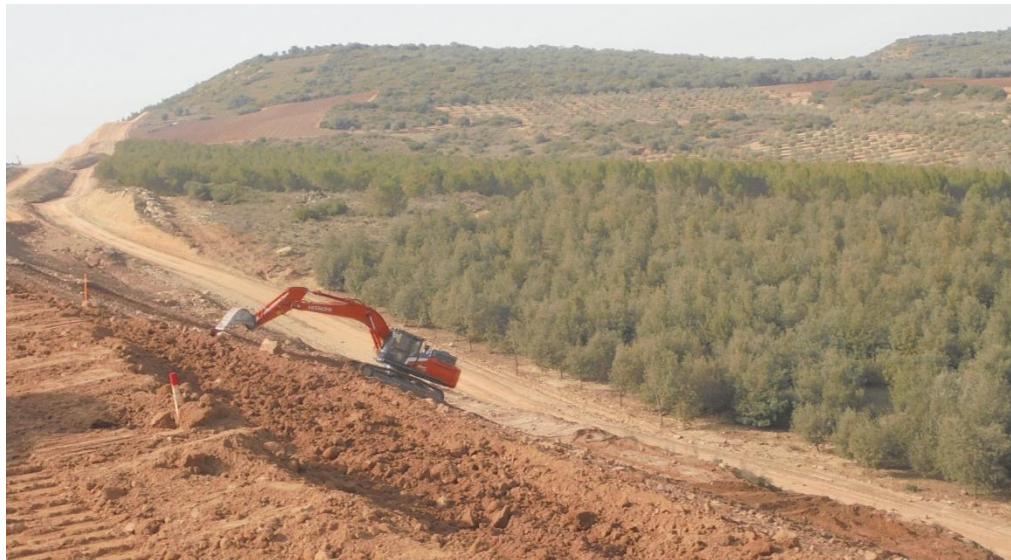
Movimiento de tierras (Recrecido de terraplenes en Conexión 2).
