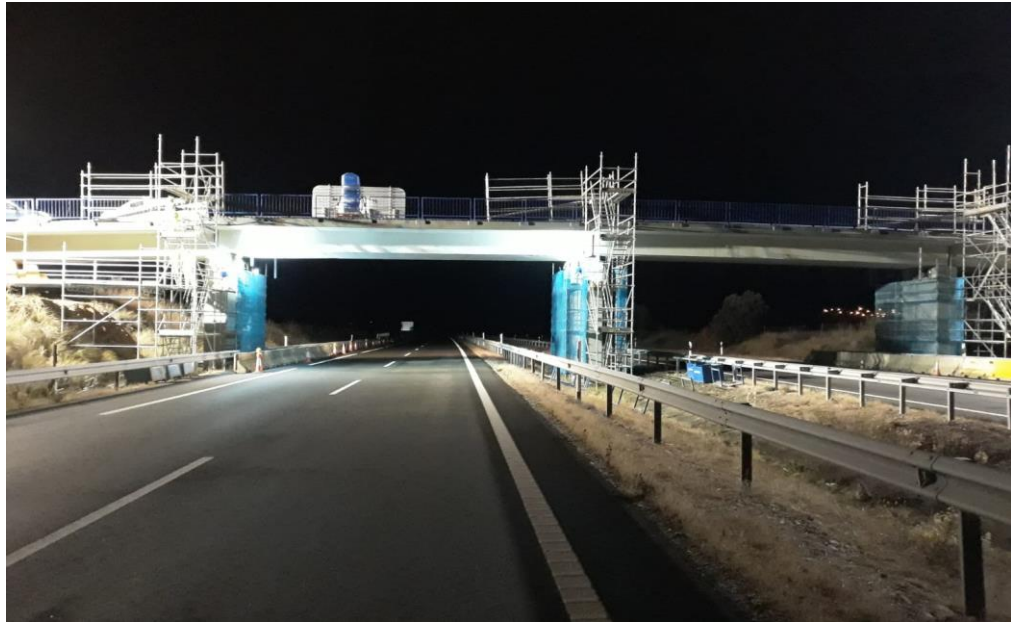
Trabajos de "gateado" en la AP-68.
