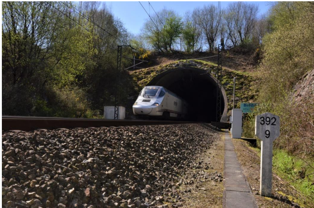
Túnel de Berdía
