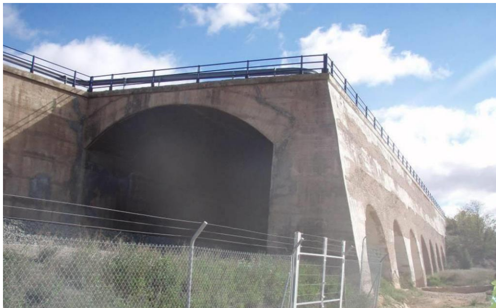
Embocadura norte y aligeramientos laterales
