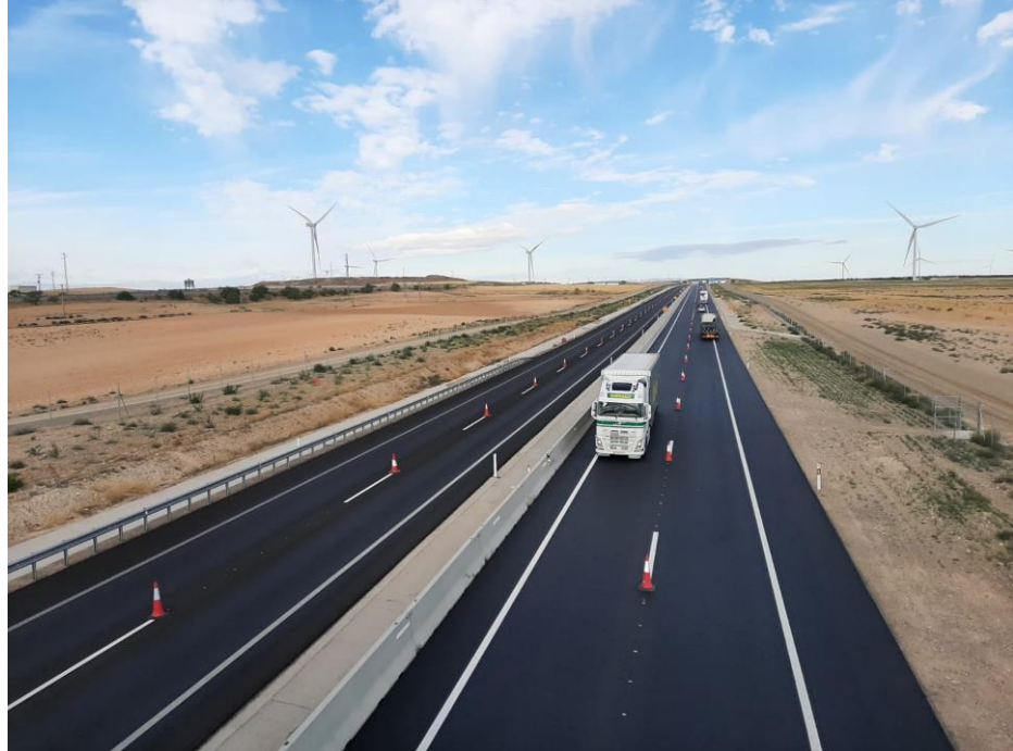
Vista general del tramo de autovía circulando por la nueva calzada en bidireccional el tráfico de la N-232
