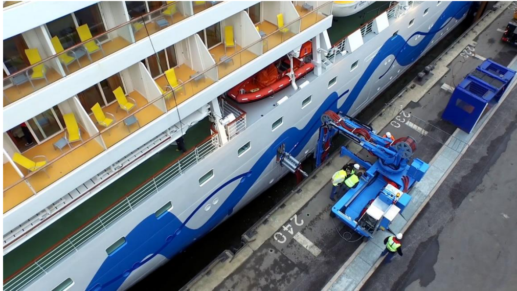
Conexión eléctrica de un buque
