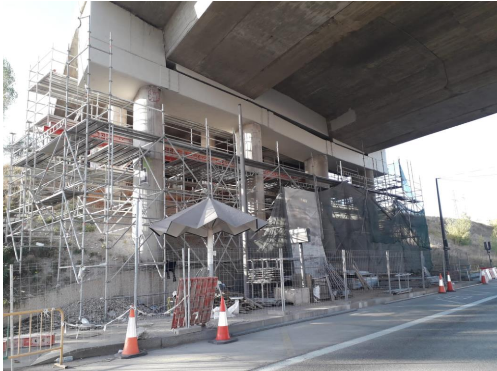
Viga transversal reparada
