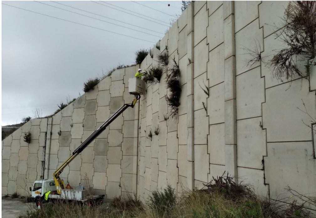
Limpieza de vegetación en muro de tierra armada
