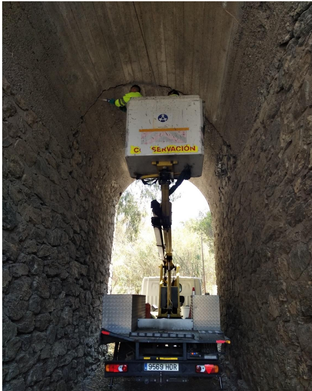
Sellado de grieta
