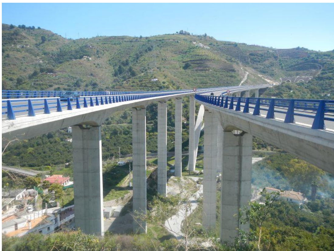
Viaducto de Río Verde. P.K. 913+400 de la autovía del Mediterráneo A-7
