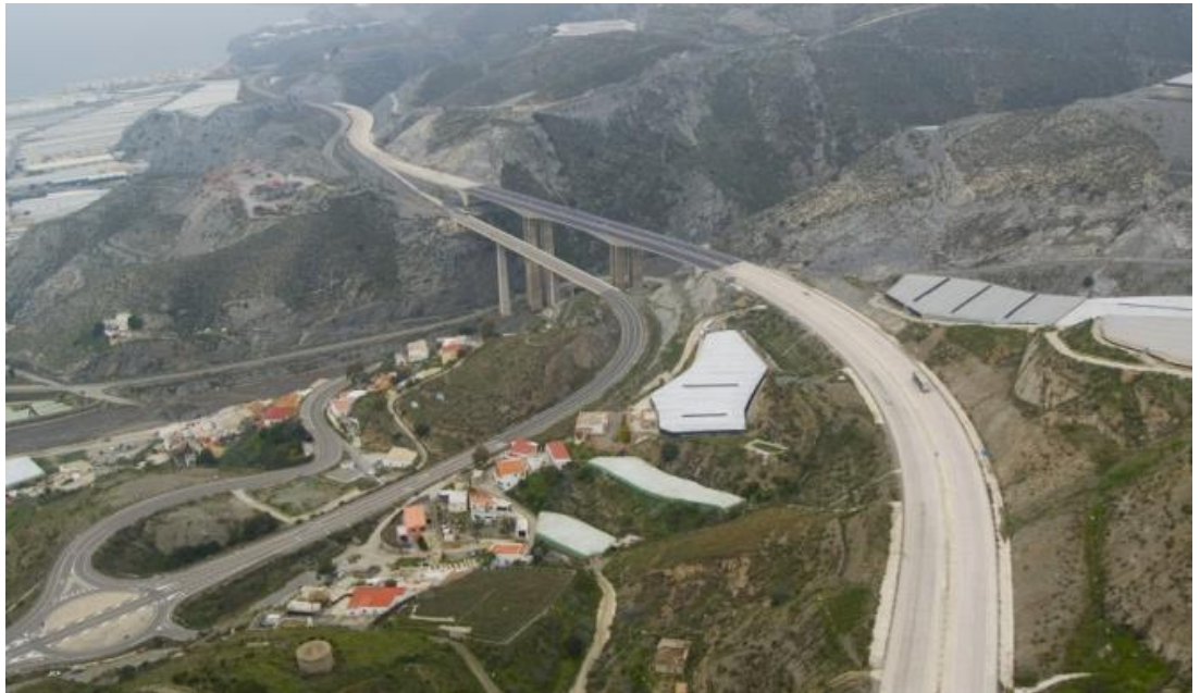
Viaducto de Huarea. P.K. 852+600 de la autovía del Mediterráneo A-7
