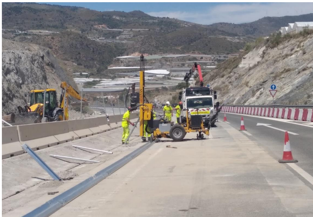
Colocación de barrera metálica
