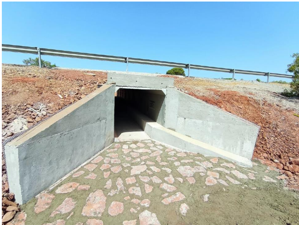
Ejecución de solera de entrada de nuevo paso de fauna
