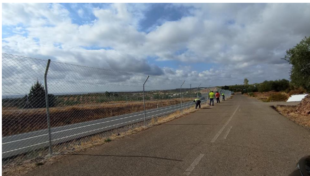
Fijaciones finales al terreno del nuevo cerramiento metálico ejecutado
