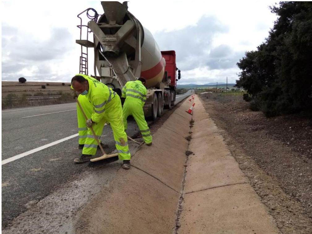
Revestimiento cunetas. N-301 p.k. 266+000, margen derecha
