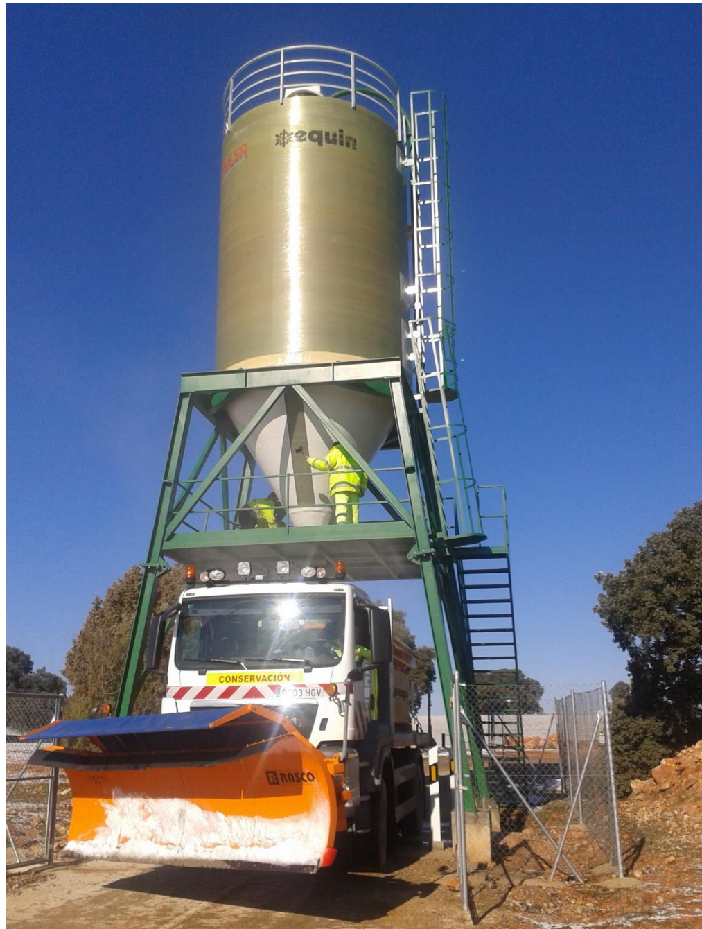
Silo. N-430 p.k. 421+110, margen derecha.
