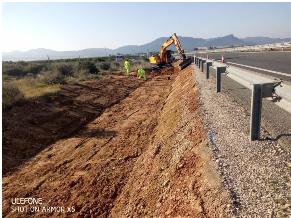
Revestimiento cunetas. A-30 p.k. 68+700 calzada izquierda (exterior)
