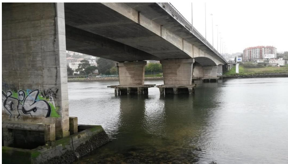
Imagen del puente actual
