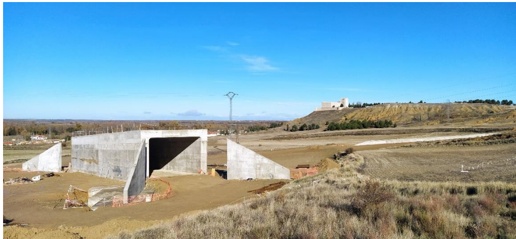
Obras en ejecución en la LAV Palencia-Santander
