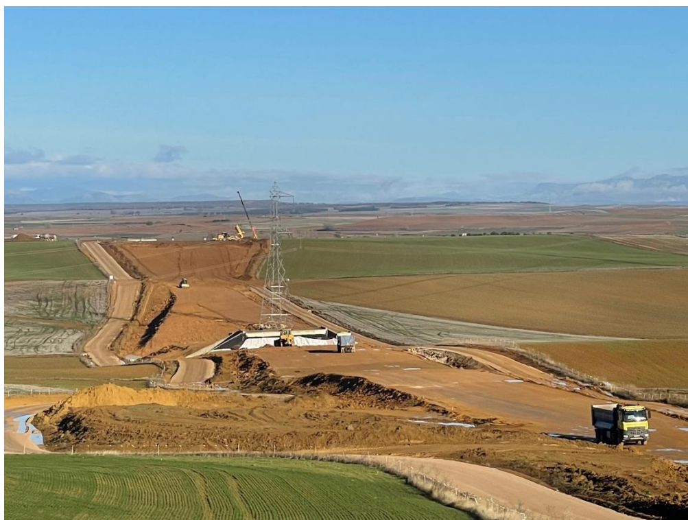
Obras en ejecución en la LAV Palencia-Santander
