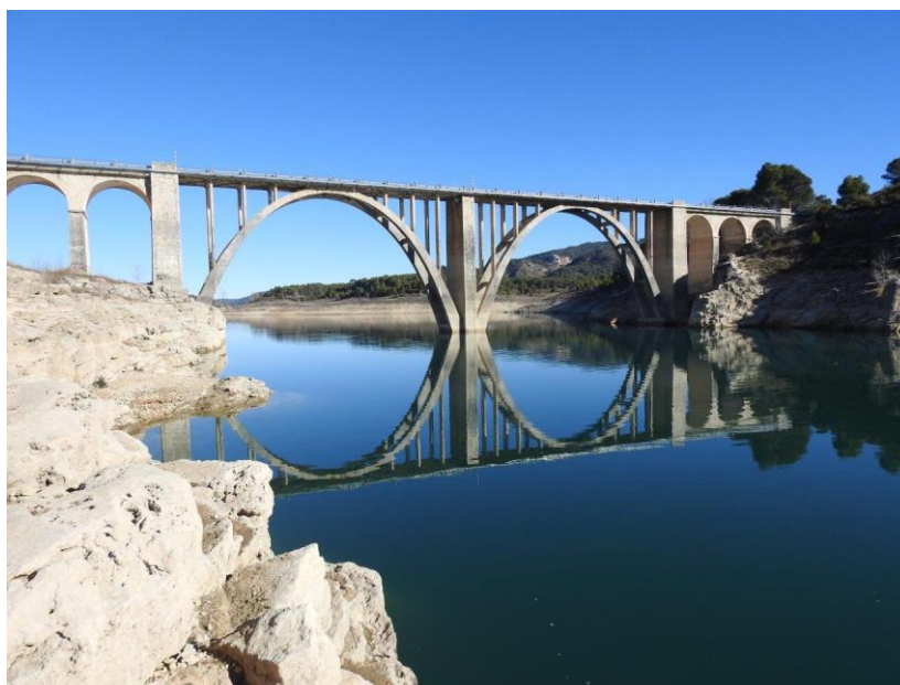
N-204 Pk 19 - Viaducto de Entrepeñas
