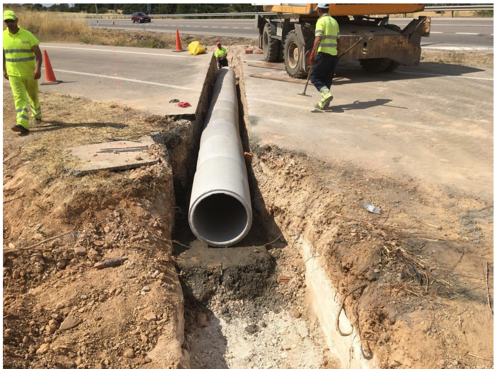
N-320 Pk 267 - Ejecución de obra de drenaje transversal
