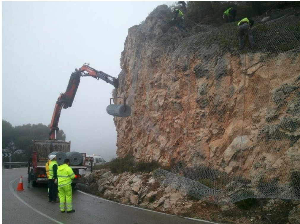
N-320 Pk 225 - Instalación de malla de protección en talud
