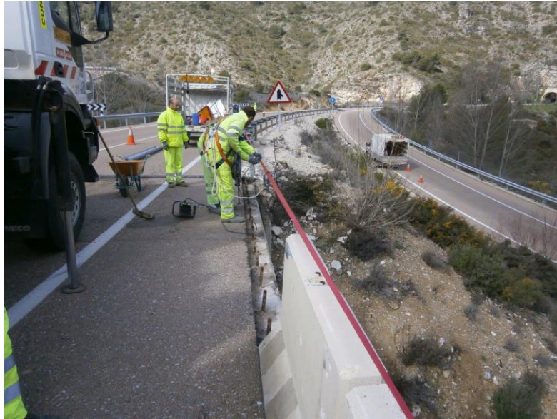
N-320 Pk 222,8 - Reparación de pretil
