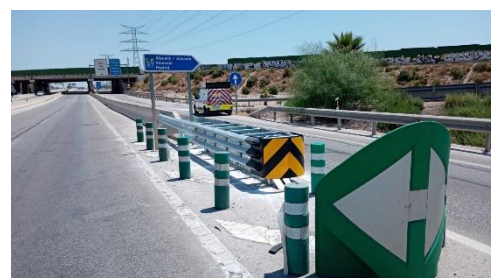
Colocación de amortiguador de impacto en nariz de enlace: antes (izquierda) y después (derecha)
