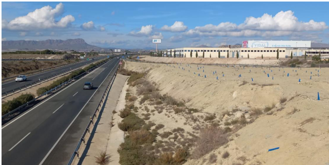
Plantación arbórea finalizada en enlace A-30 P.K. 98.
