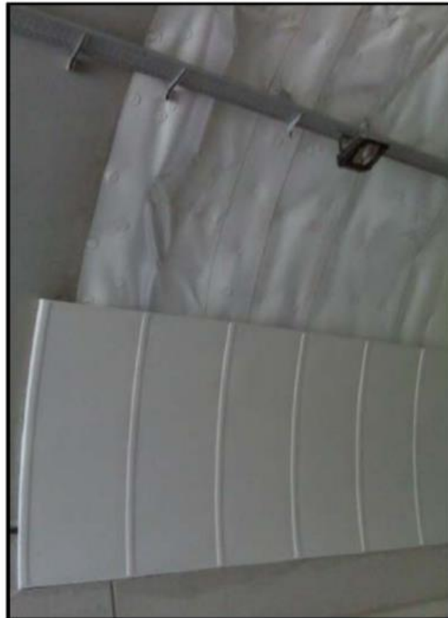
Ejemplo de resultado final tras sistema de impermeabilización en el túnel de Madroño
