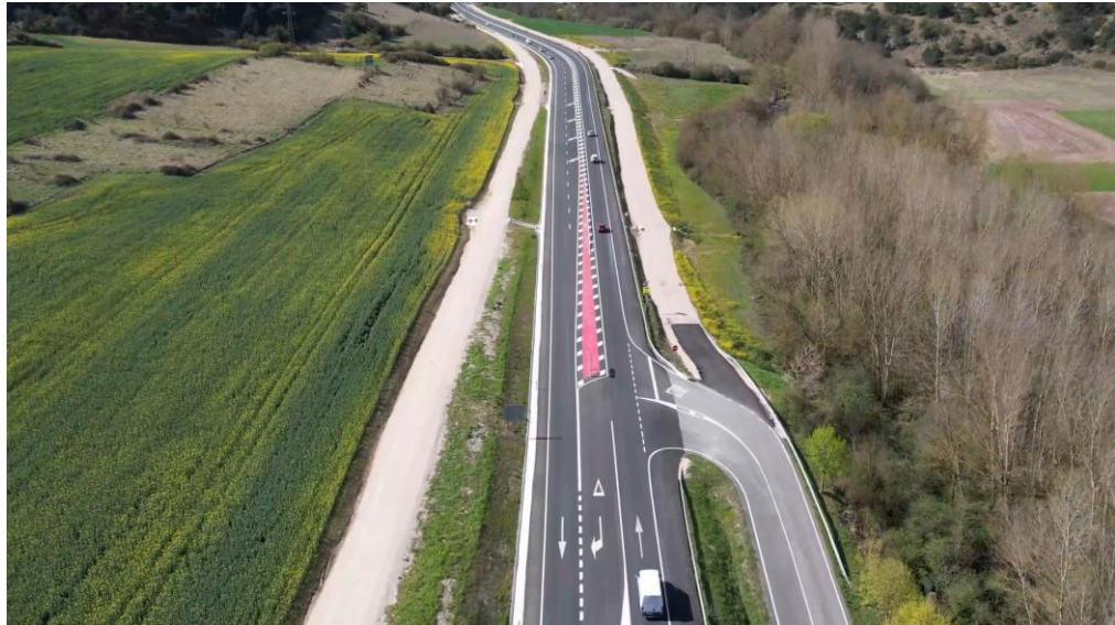
Tramo 2+1 desde los túneles de Ezcaba hasta Olave ya ejecutado de la carretera N-121-A.
