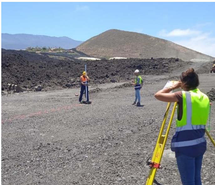
Imágenes de la ejecución de la nueva carretera entre Puerto Naos y Tzacorte
