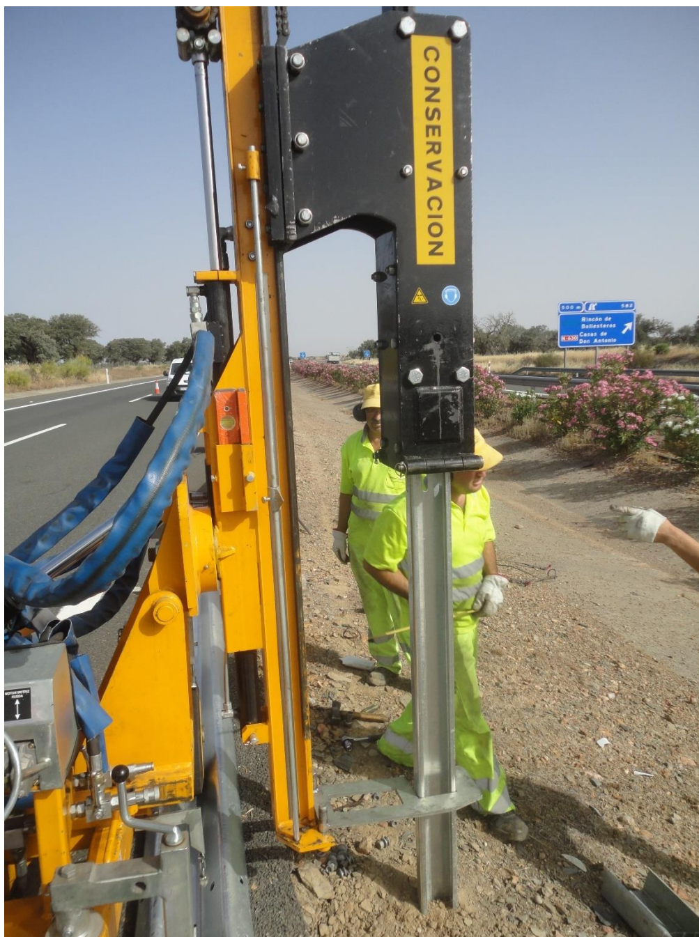
A-66. P.K 585. Colocación de barrera seguridad
