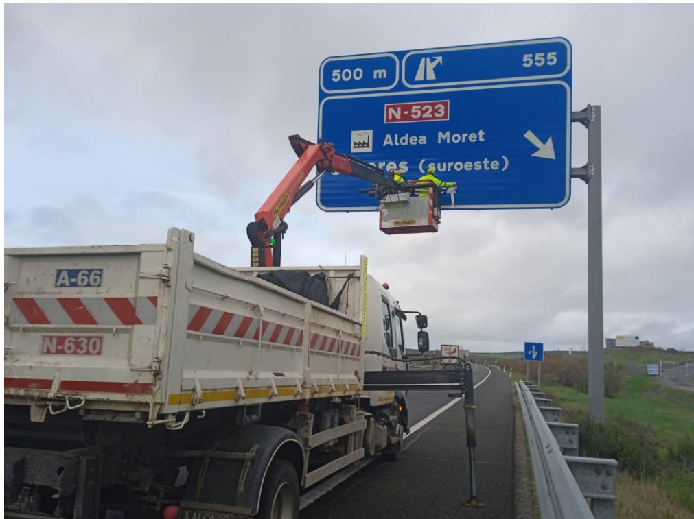
A-66. P.K. 555. Colocación de cartel
