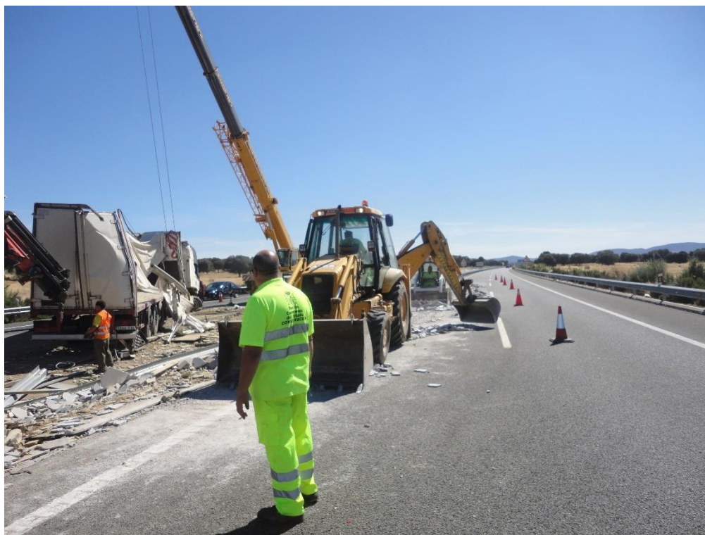
A-66. Atención de accidentes e incidentes (retirada de carga)
