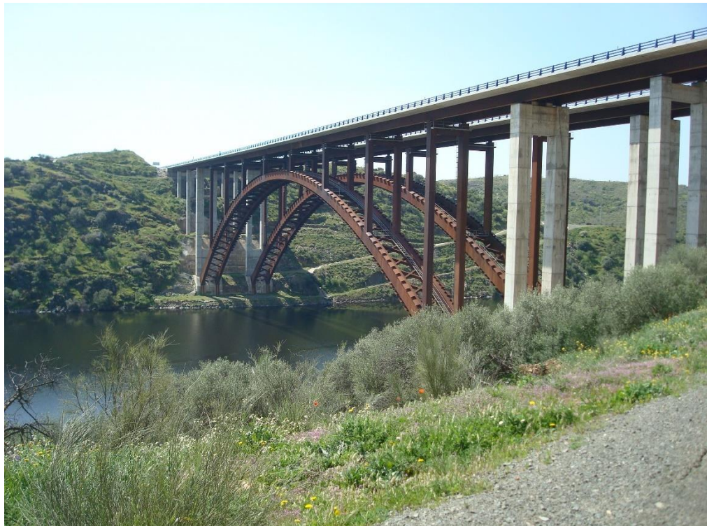
A-66. P.K.520. Viaducto sobre el río Tajo
