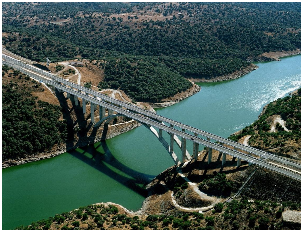
A-66. P.K.532. Puente sobre el Río Almonte
