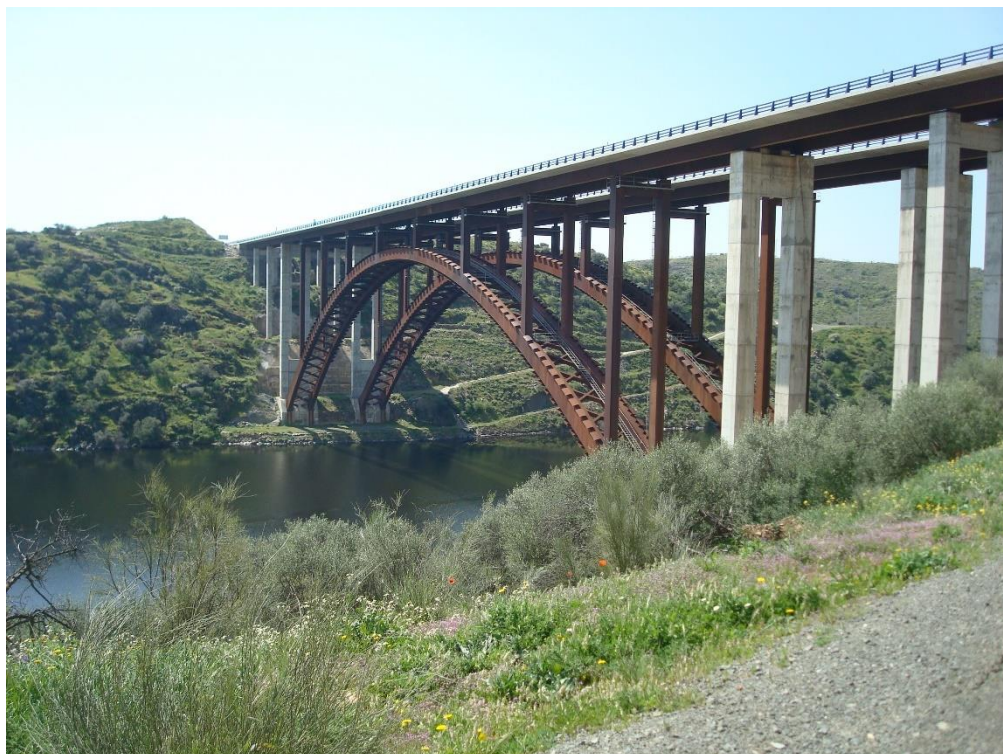
A-66. P.K.520. Viaducto sobre el río Tajo
