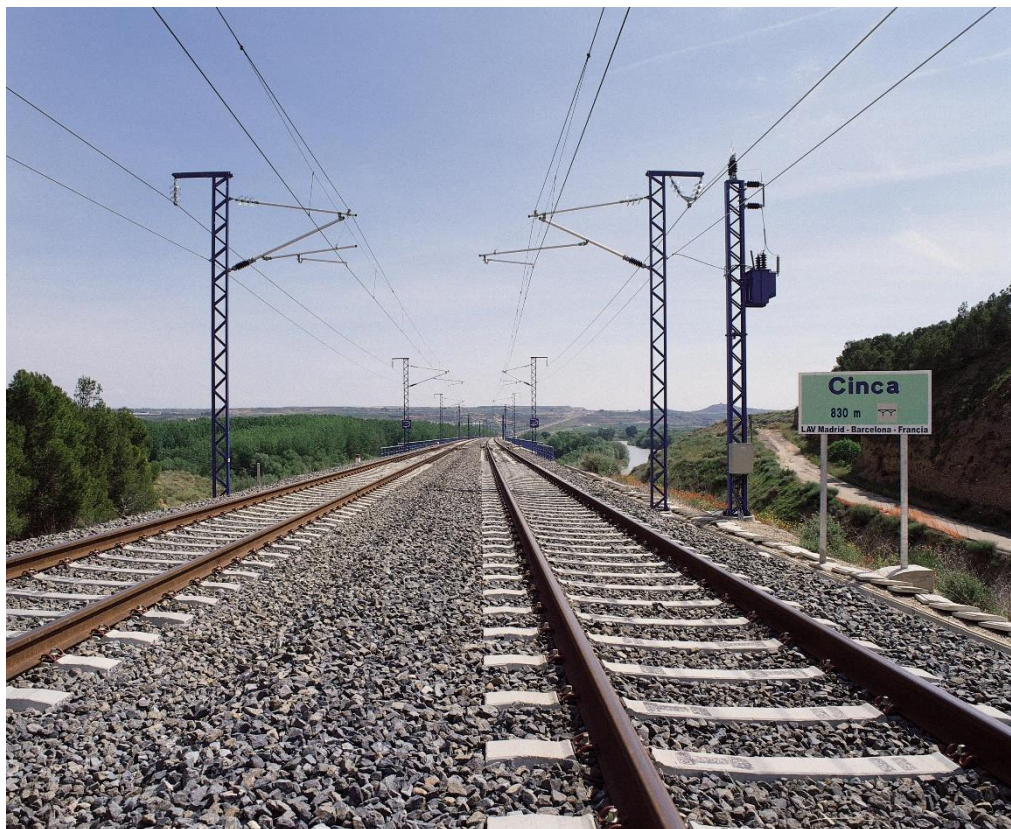
LAV Madrid-Barcelona. Viaducto Cinca
