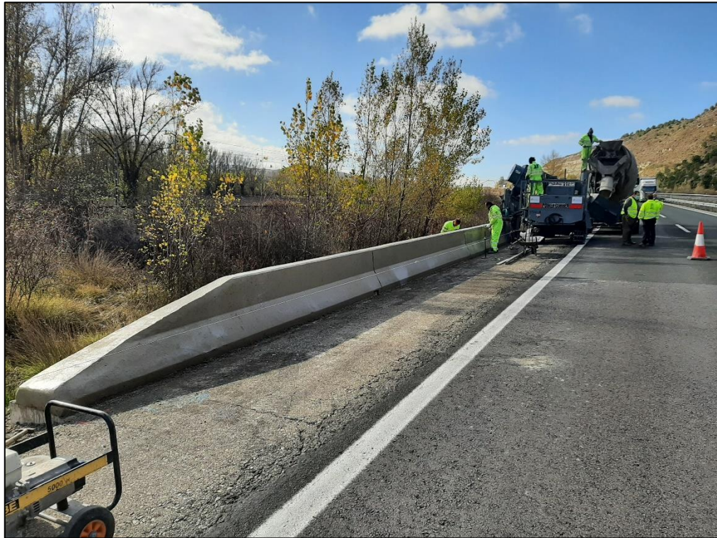
Modernización y mejora de sistemas de contención.
