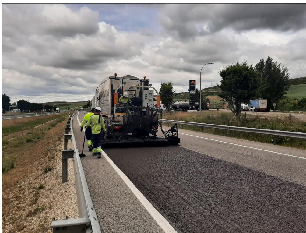
Rehabilitación del firme.
