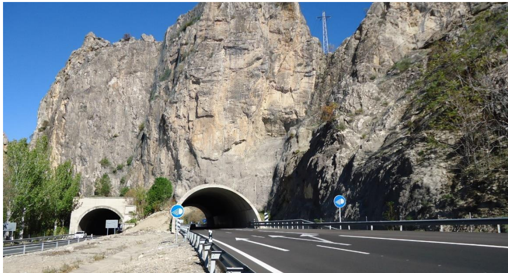
A-44. Túneles de Santa Lucía
