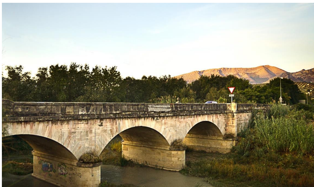
N-323. Puente sobre el río Jaén
