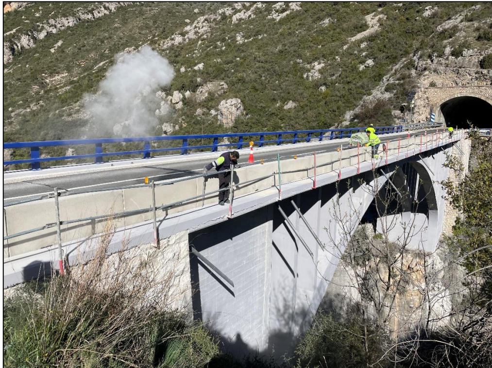
Trabajos sobre el puente.
