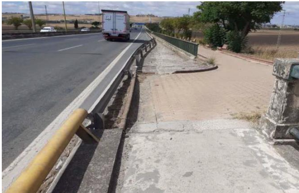
Aspecto actual de vial adoquinado de acceso al puente
