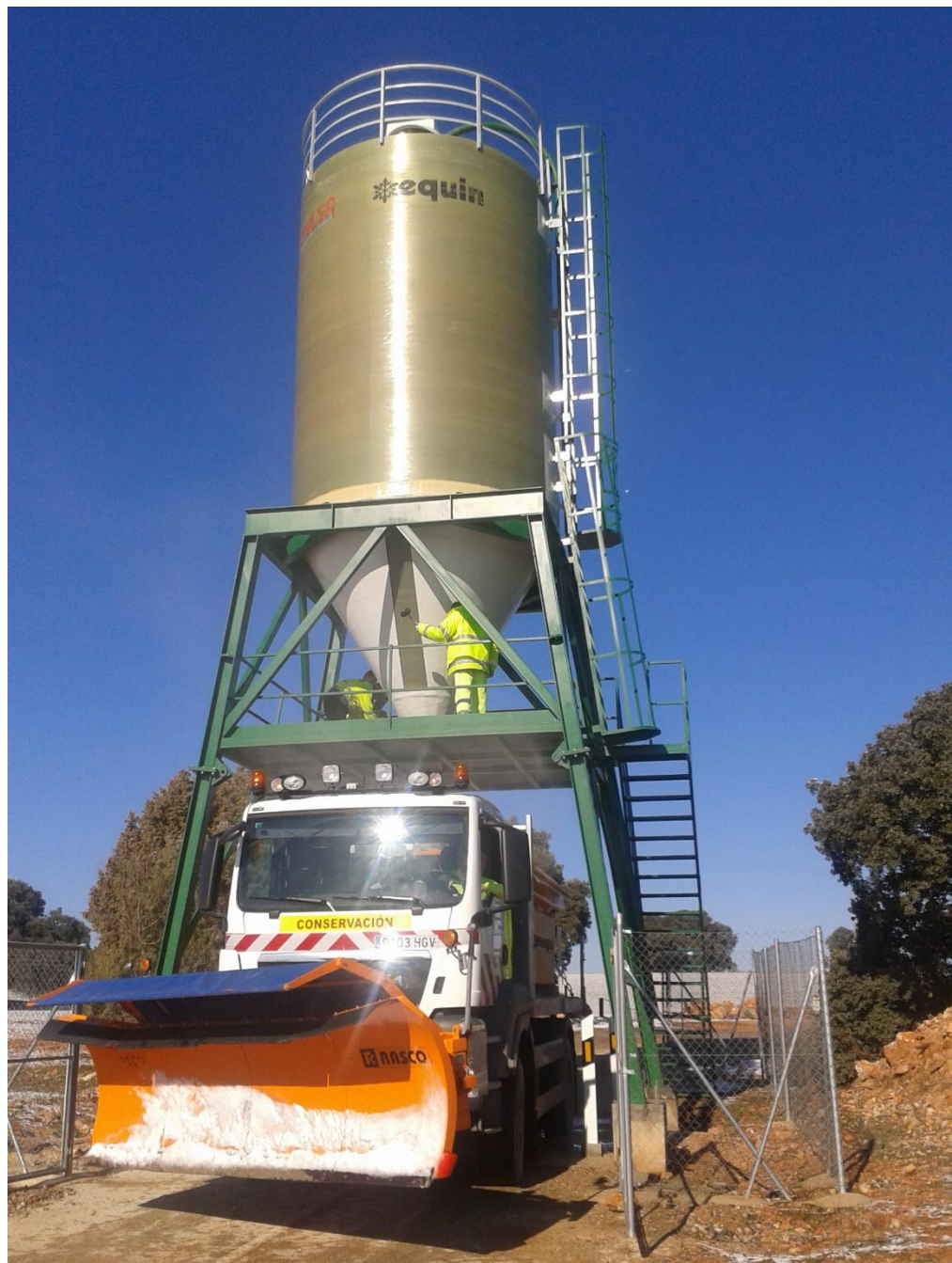
Silo. N-430 p.k. 421+110, margen derecha.
