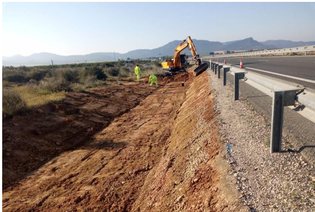
Revestimiento cunetas. A-30 p.k. 68+700 calzada izquierda (exterior)
