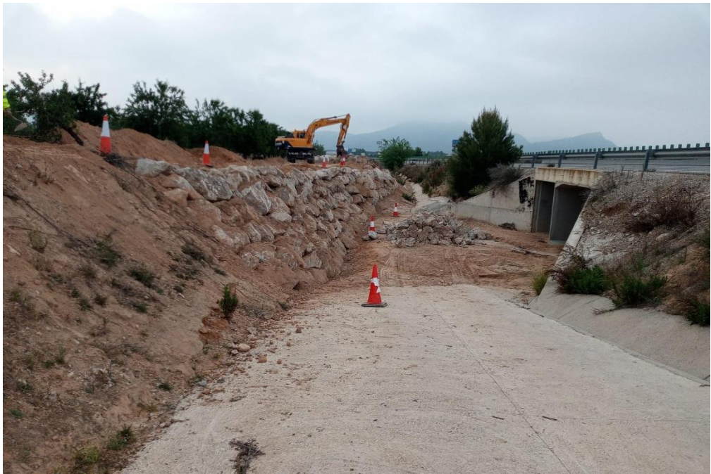
Obra escollera. N-301 p.k. 321+800, margen izquierda
