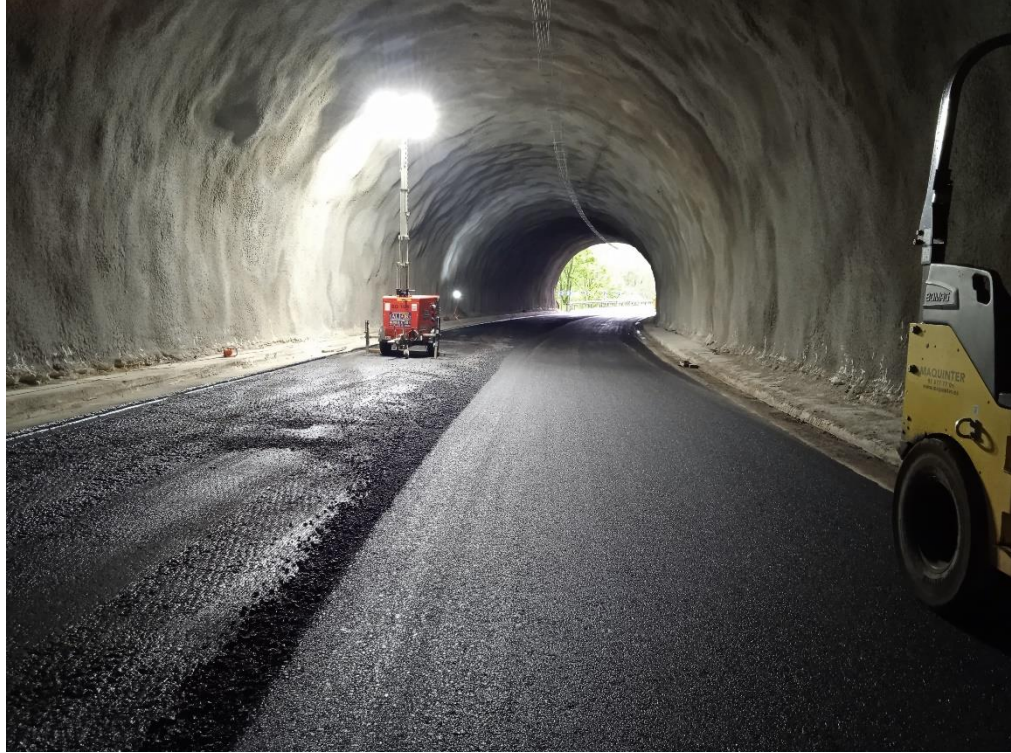
Ilustración 1. Extendido de la capa de rodadura en uno de los carriles de circulación.
