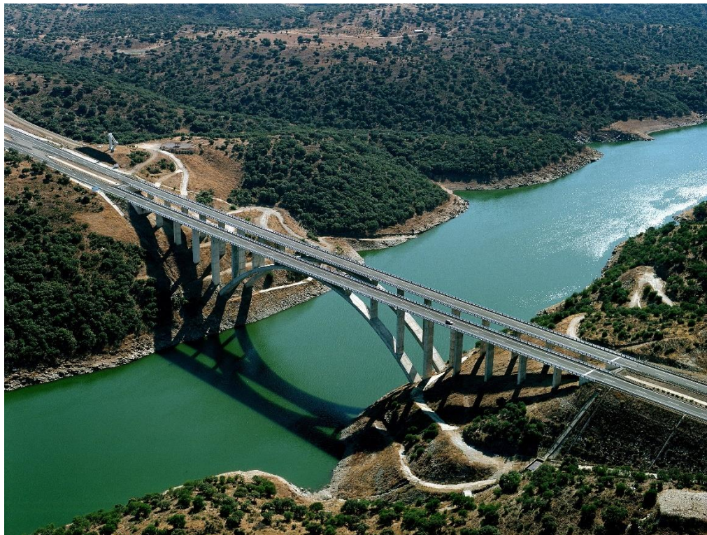
A-66. P.K 532. Puente sobre el Río Almonte
