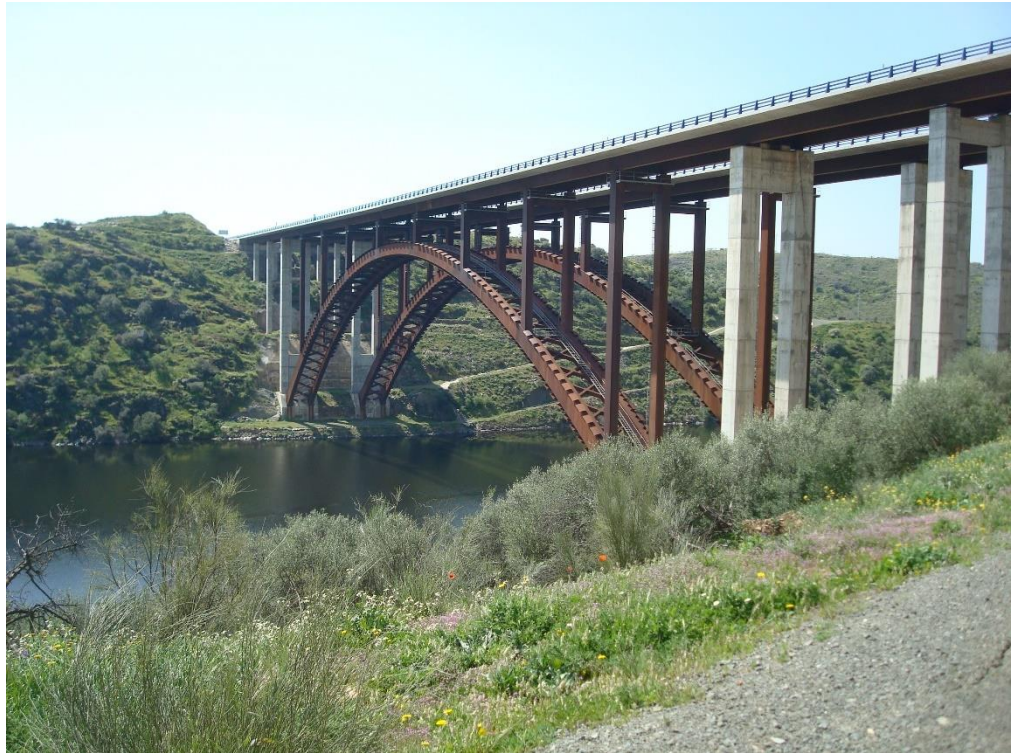
A-66. P.K.520. Viaducto sobre el río Tajo
