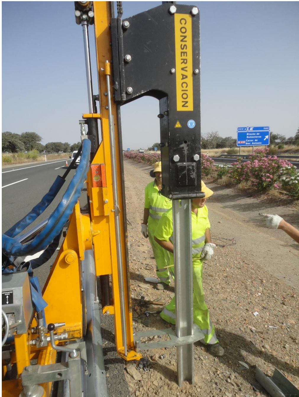
A-66. P.K 585. Colocación de barrera seguridad
