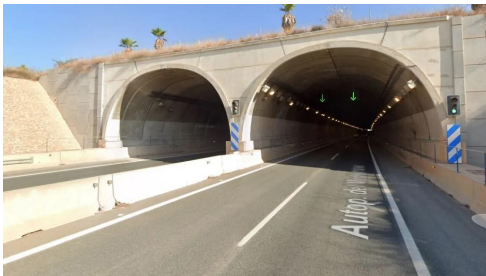
Túnel de Pilar de la Horadada. AP-7
