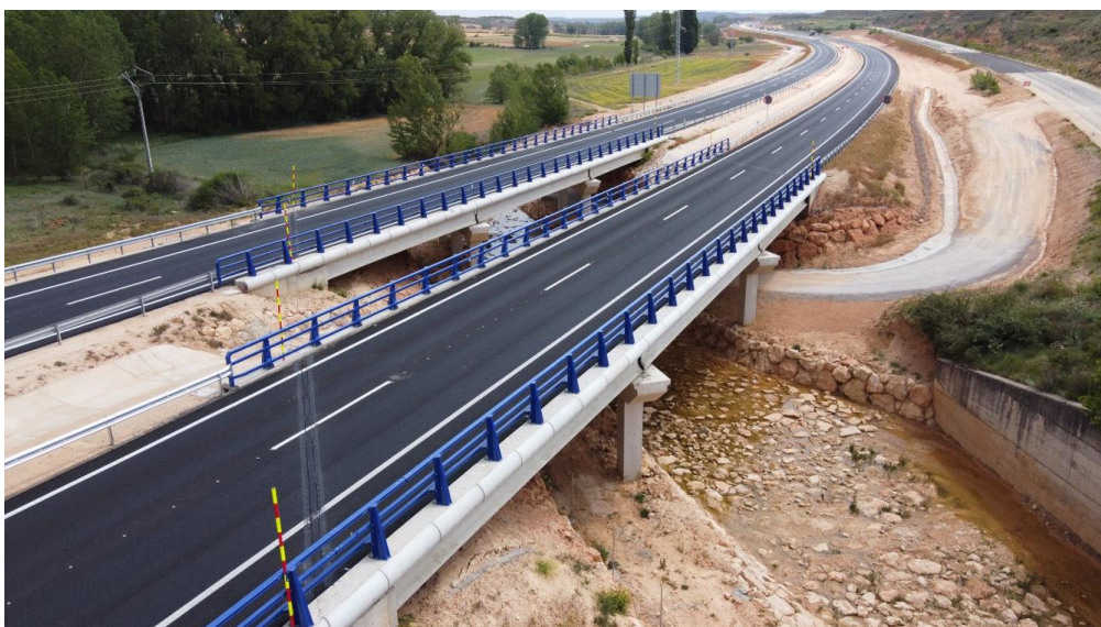
Ilustración 7. Viaducto sobre el Arroyo Torderón
