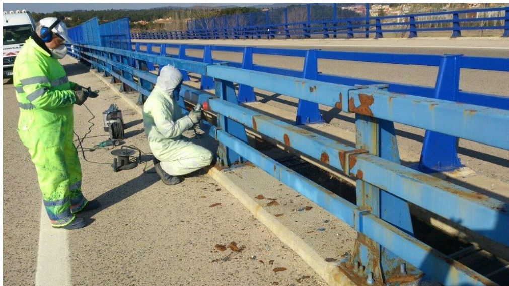
Trabajo de repintado de pretil. A-40, km 304,600, calzada derecha
