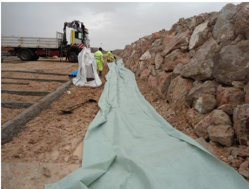
Colocación de geotextil de drenaje. A-40; km 250
