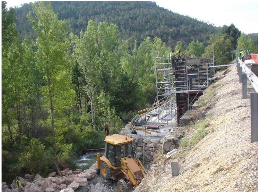
Reparación de muro. N-420, km 494,100
