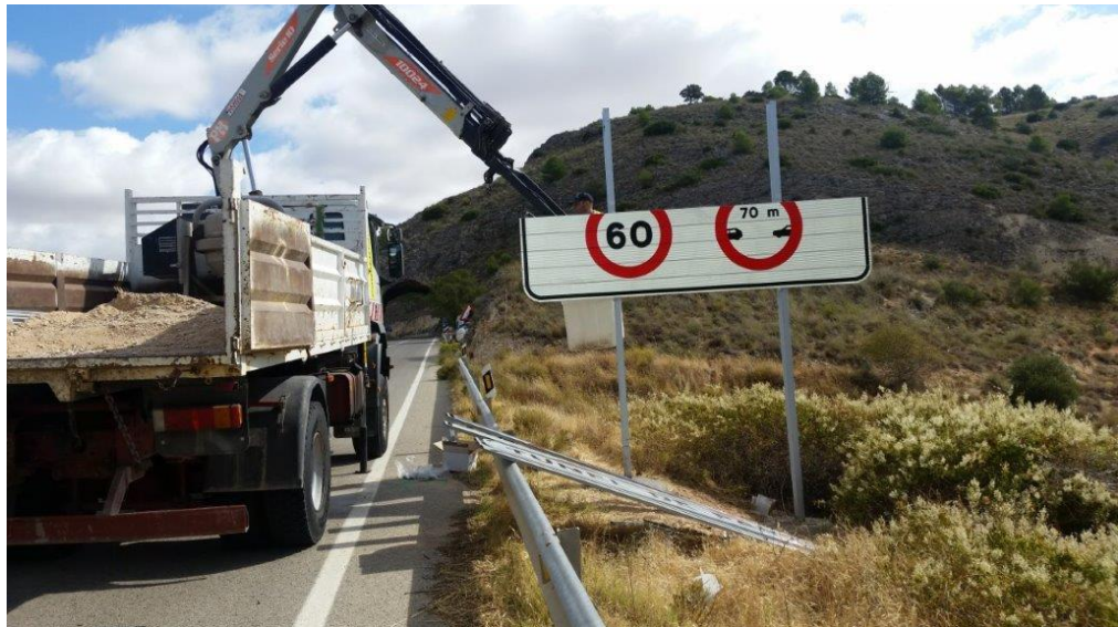
Instalación de cartel. N-400, km 111,200
