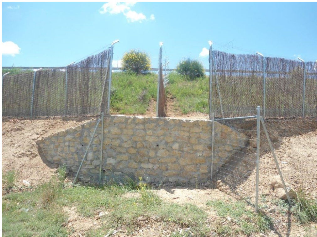
Salto de fauna A-40, km 293,560, calzada izquierda
