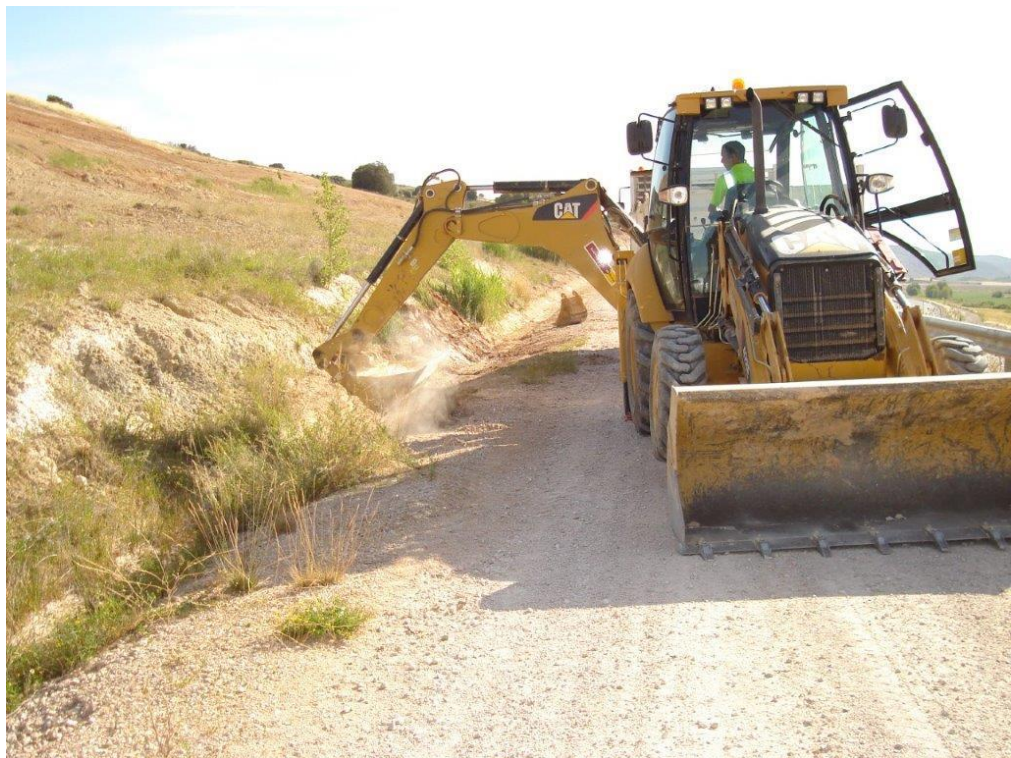
Limpieza de cuneta en camino servicio. A-40, km 271,800.
