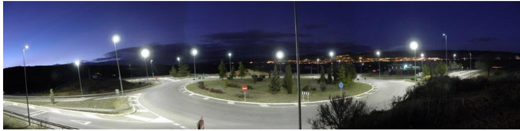
Sustitución luminarias a led N-320, km 137,200
