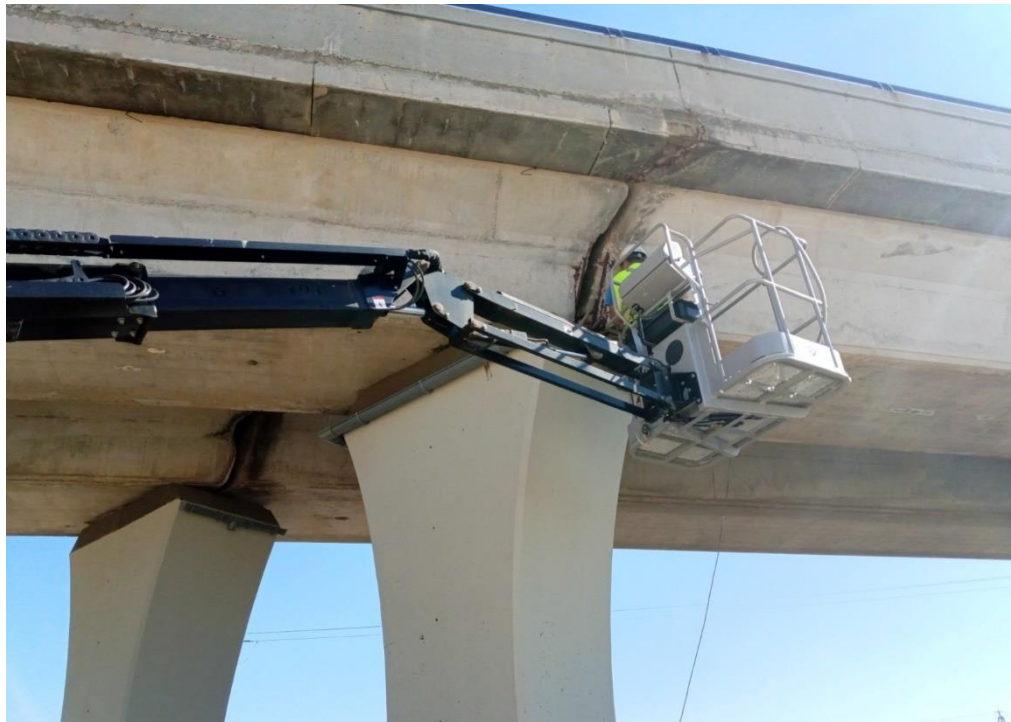
Reparación de estructuras
