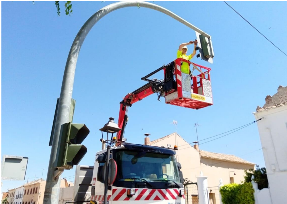
Sustitución de lámparas en semáforos
