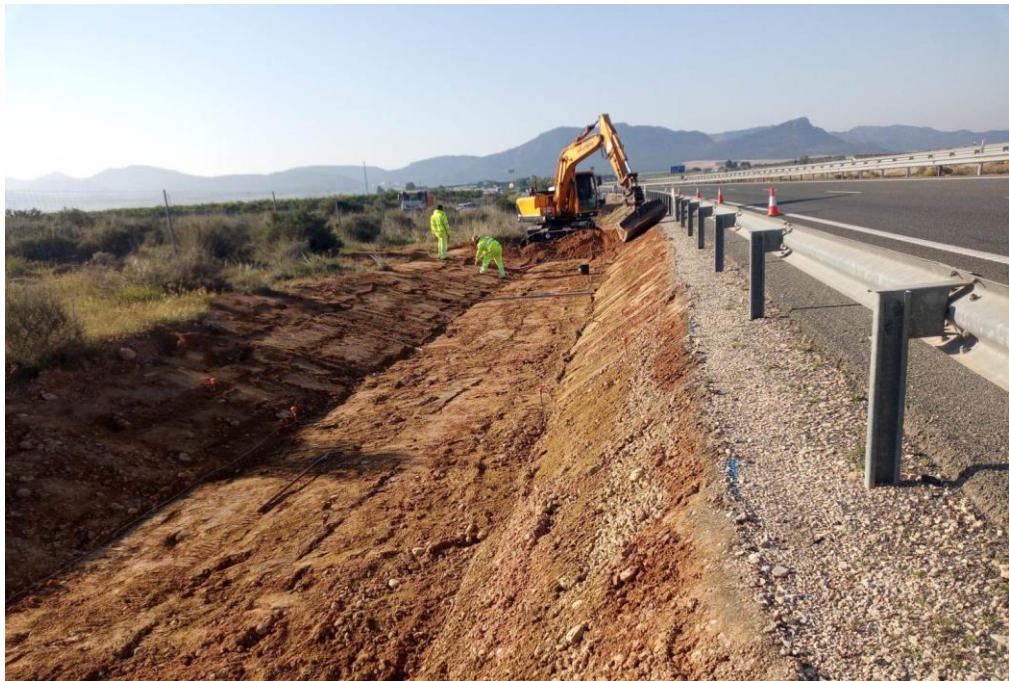
Revestimiento cunetas. A-30 p.k. 68+700 calzada izquierda (exterior)
