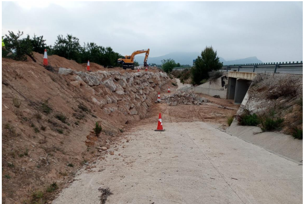
Obra escollera. N-301 p.k. 321+800, margen izquierda
