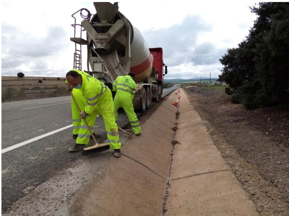
Revestimiento cunetas. N-301 p.k. 266+000, margen derecha
