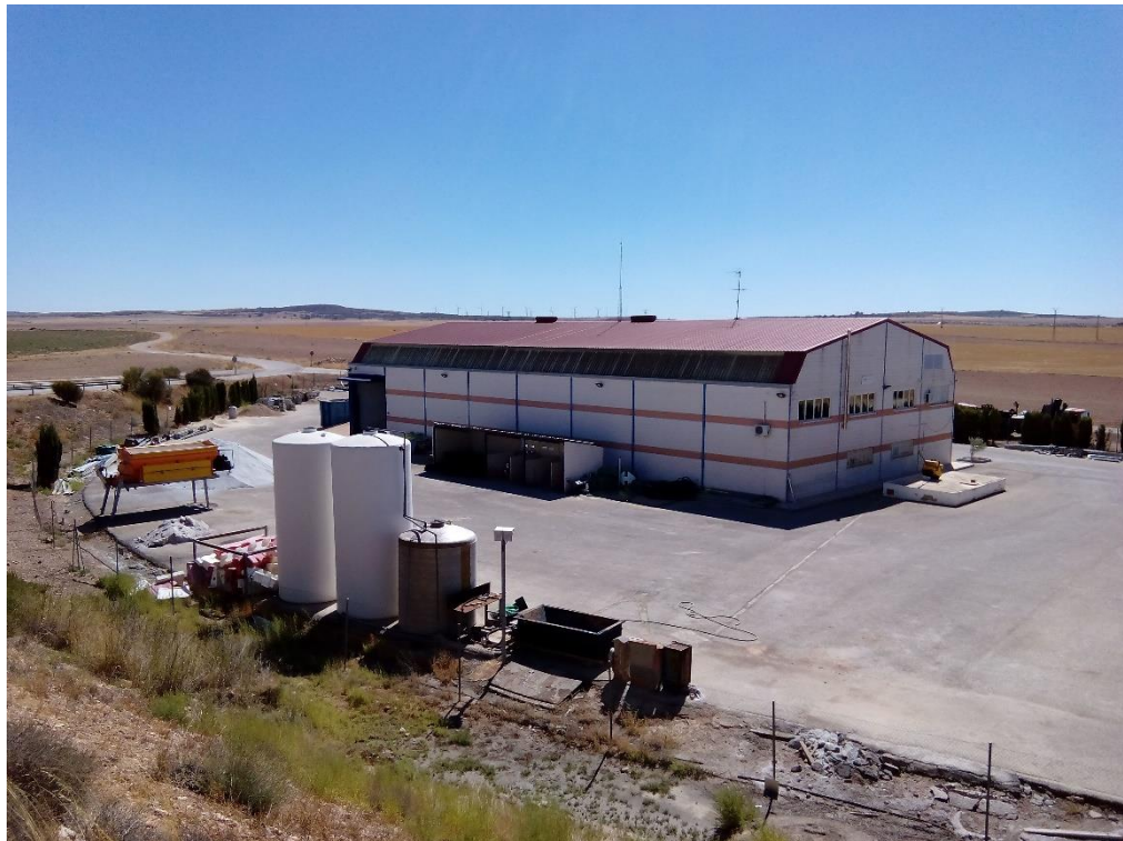
Centro de conservación (exteriores). A-30 p.k. 05+950 calzada izquierda (exterior)
