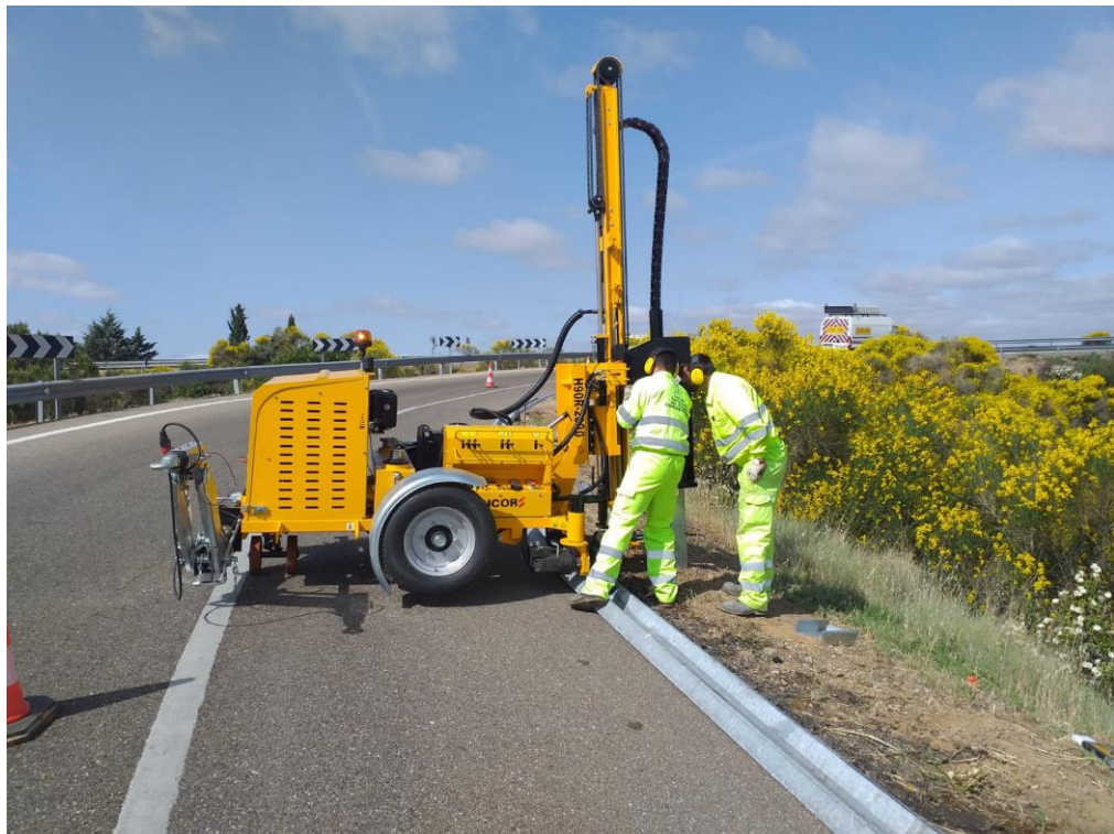
Colocación barrera seguridad ZA-13 PK 2+000
