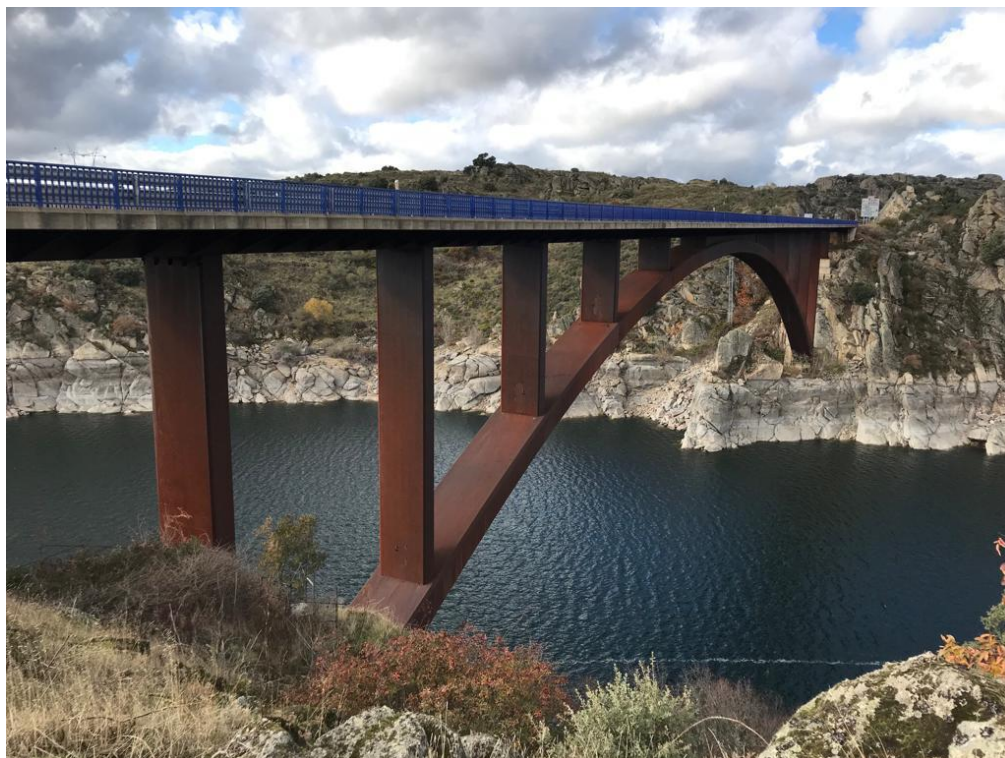
Viaducto sobre embalse de Ricobayo N-122 PK 480+150
