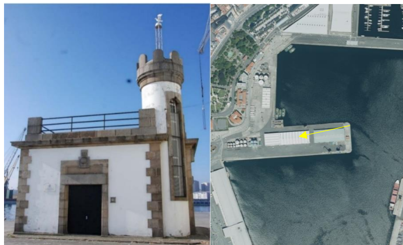
Fig 1. Vista general estado actual del edificio. Fig 2. Ubicación en el puerto de A Coruña
