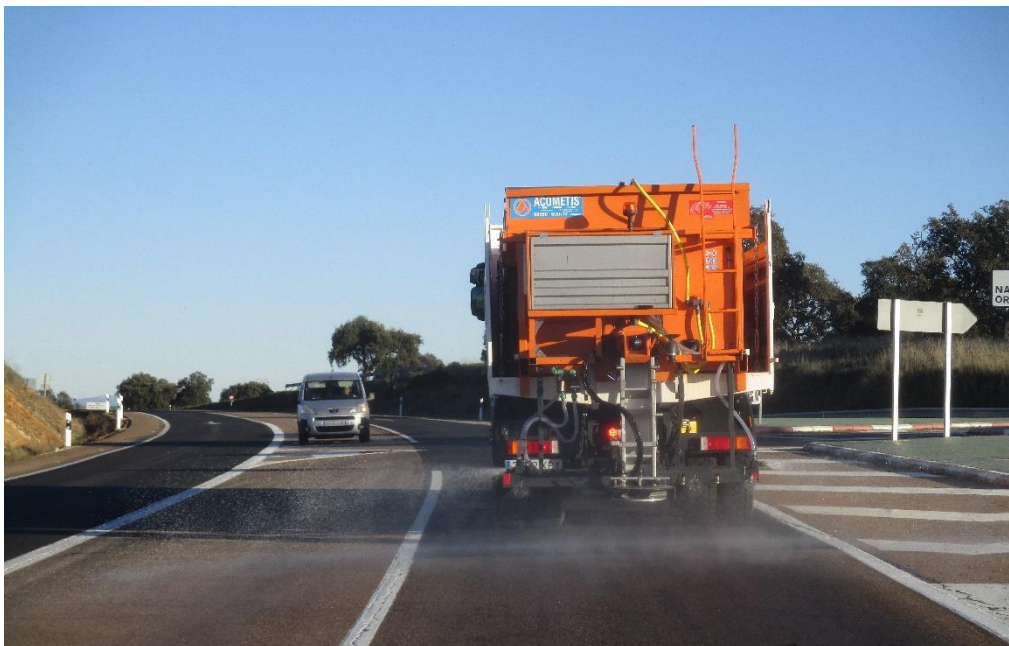
Extendido de fundentes. N-430, km 145,5
