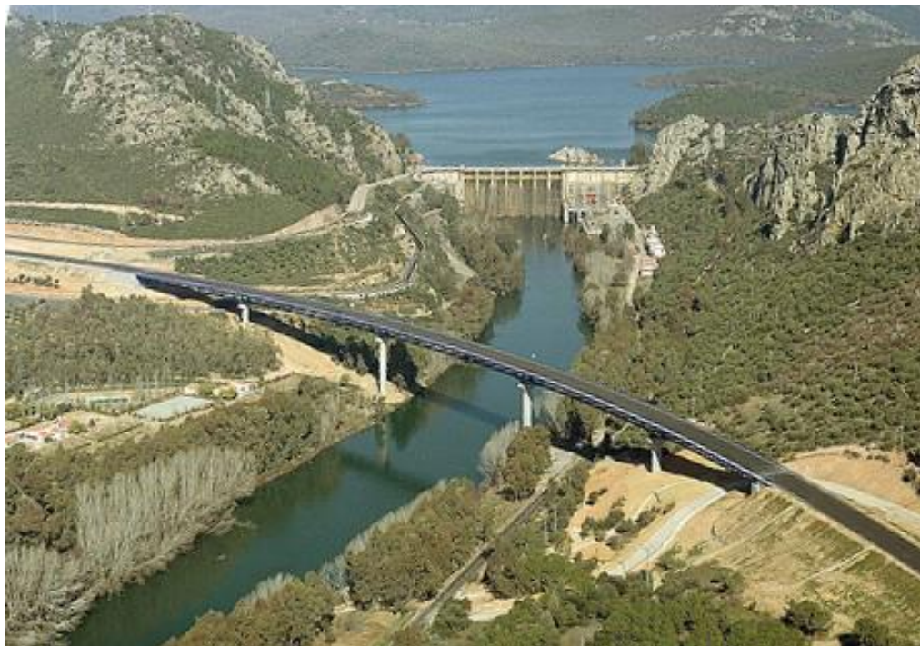
N-430, km 168. Viaducto sobre el río Guadiana. Vista aérea.
