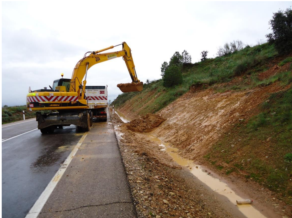
Retirada desprendimientos. N-430, km 112
