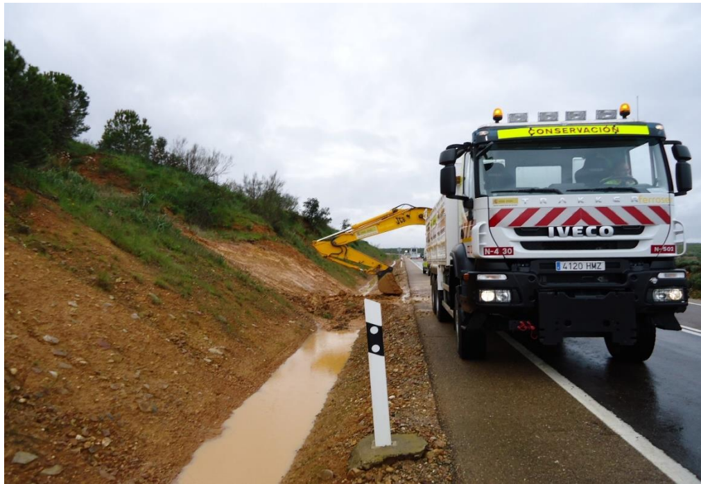
Retirada desprendimientos. N-430, km 112
