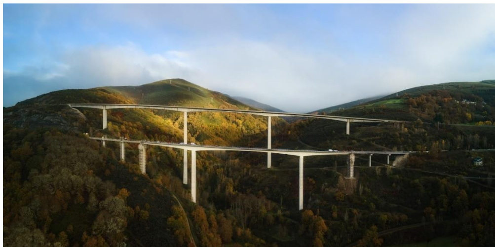
Viaductos Ruitelán y Samprón A-6 km 424
