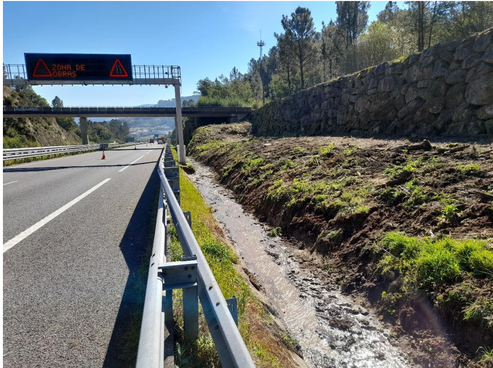
Señalización de obras A-52, km 254,050
