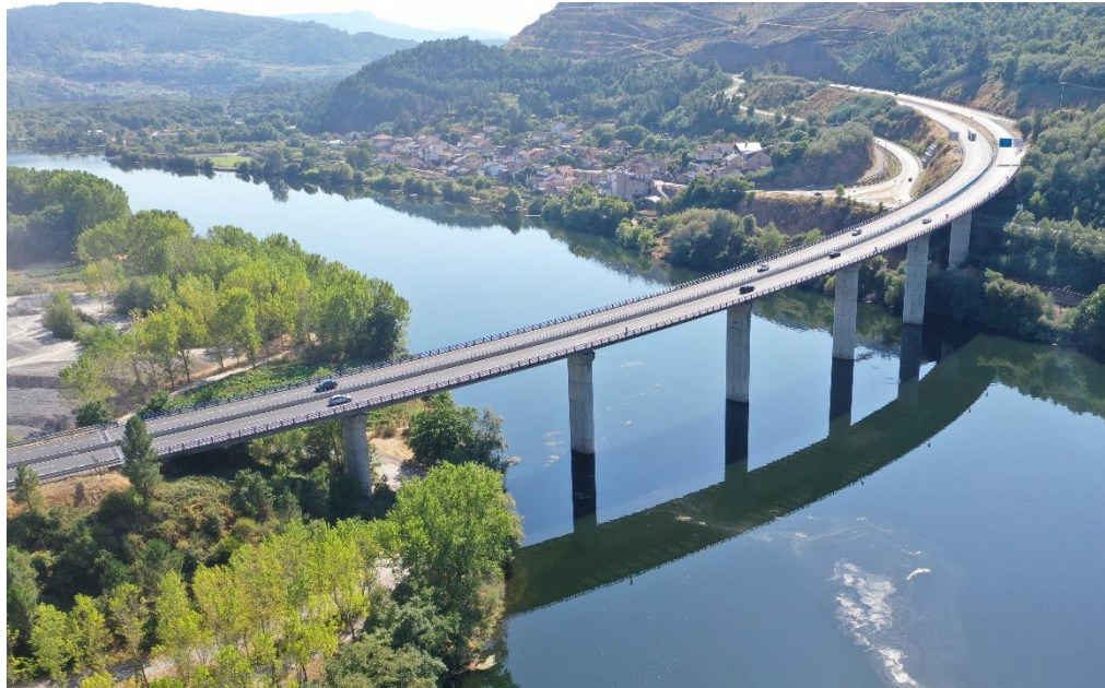
Viaducto Rio Miño A-52 km 240,100
