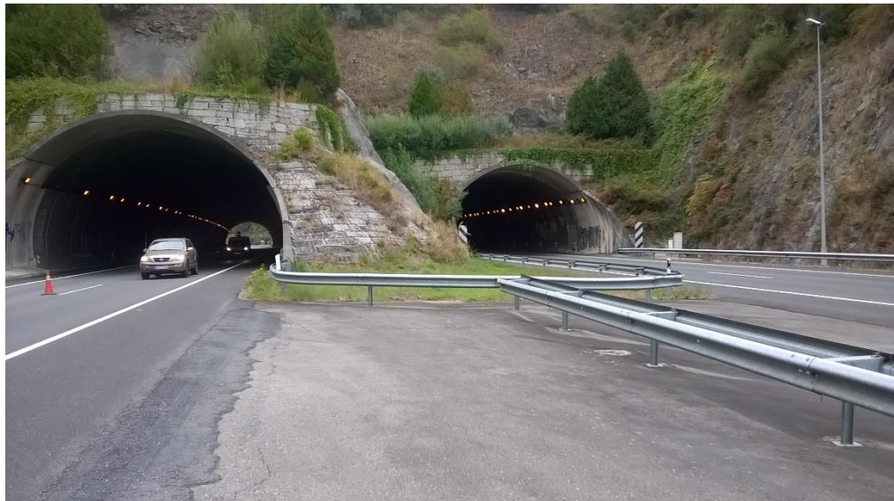
Túnel de Alongos A-52, km 235,7
