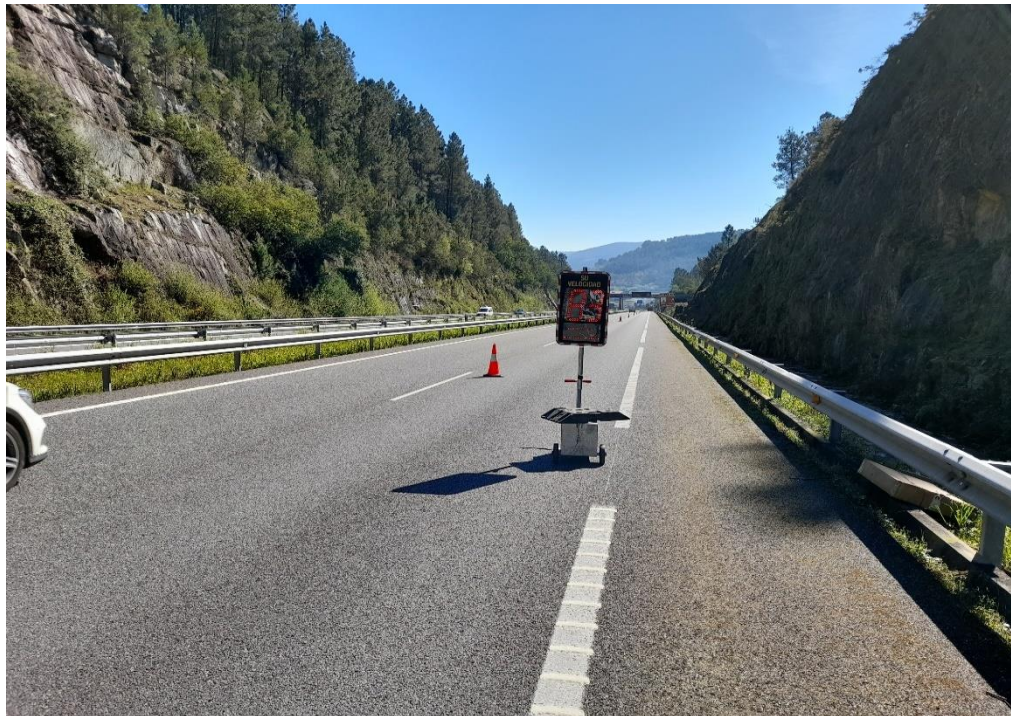
Señalización de obras con radar disuasorio A-52 km 254,400
