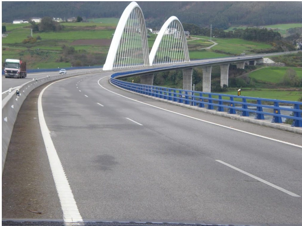
Viaductos ríos Anleo y Navia km 479,313, A-8
