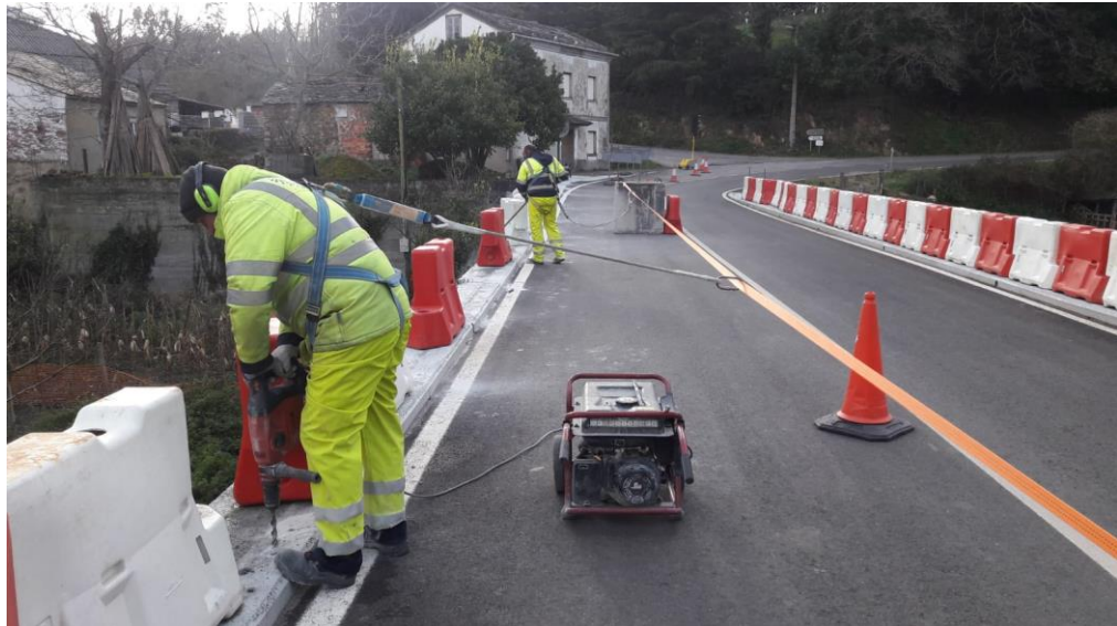
Instalación pretil Puente del Esquilo km 0,340 N-640A
