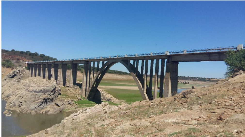
N-631 km 2,200 y 2,500 Puente la Estrella
