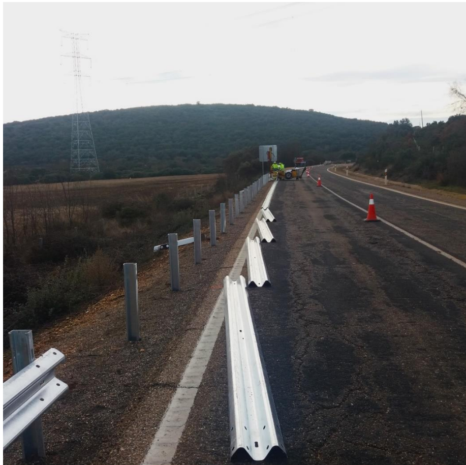
N-631 km 10,415 MD Colocación de barrera
