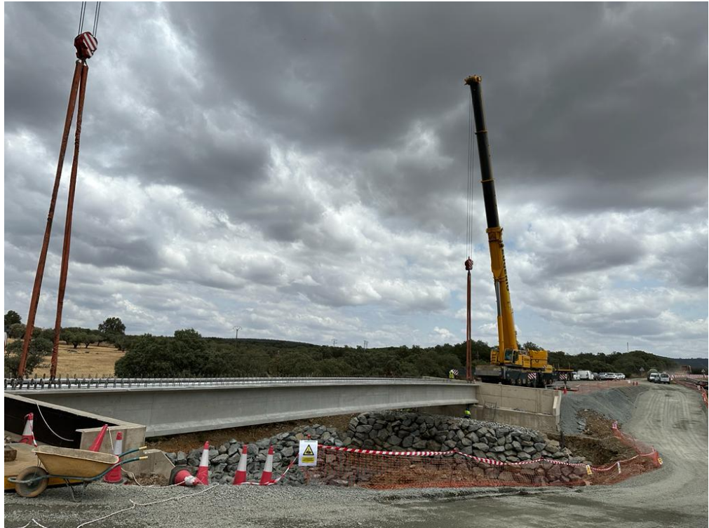
N-523, km 45. Colocación de las vigas de la nueva estructura
