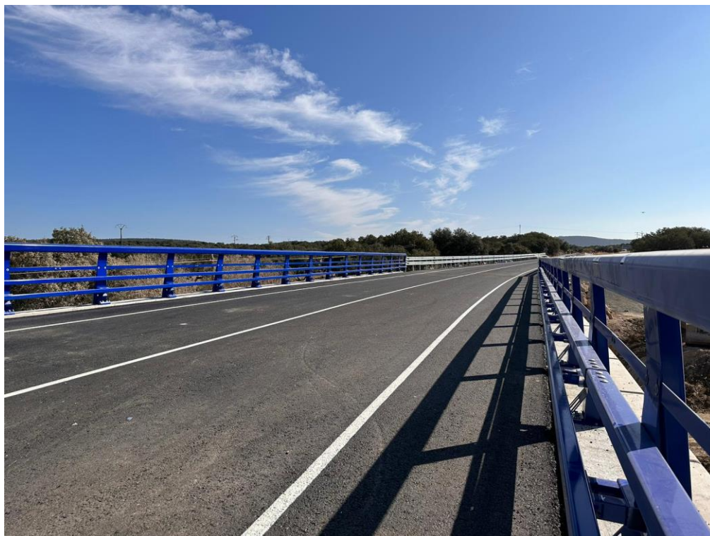
Nuevo puente sobre el Arroyo Rivera de la Troya en la N-523
