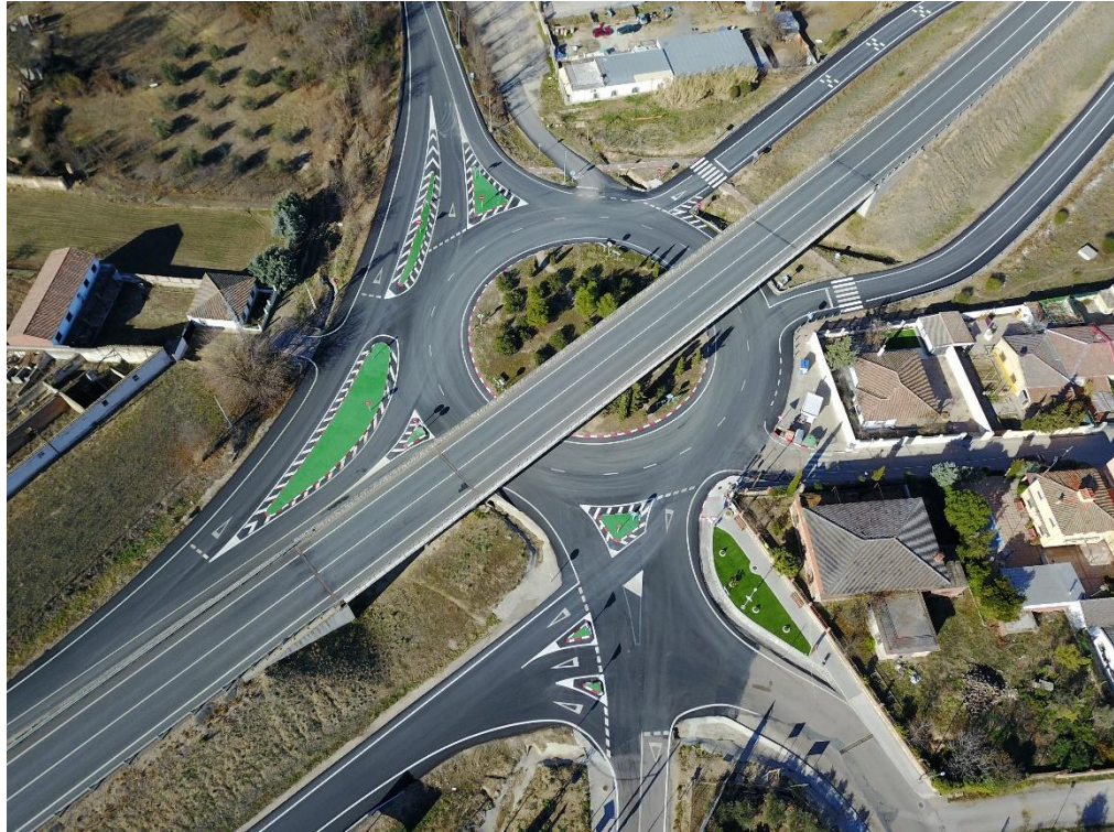
Refuerzo de Firme-Construcción Senda Peatonal N-403, km 52,300
