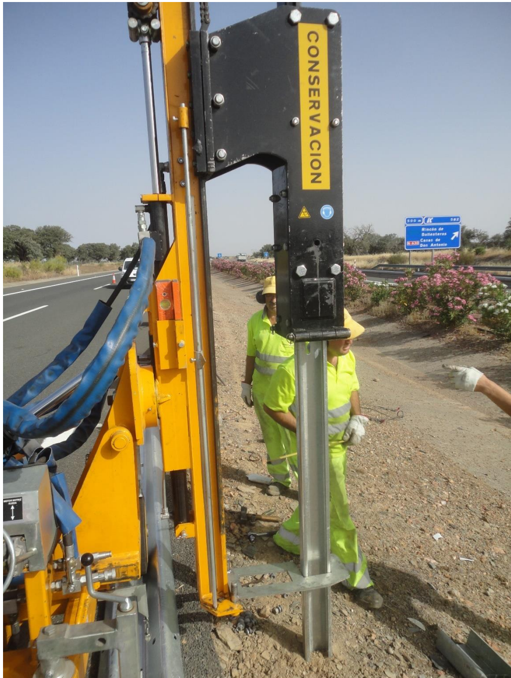
A-66. P.K 585. Colocación de barrera seguridad
