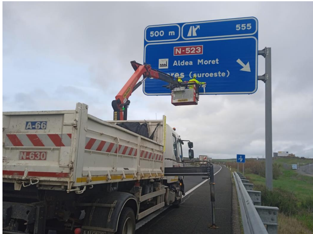
A-66. P.K. 555. Colocación de cartel
