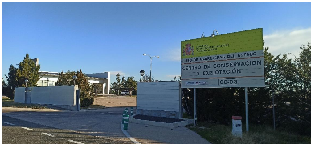
N-630. Centro de conservación y explotación
