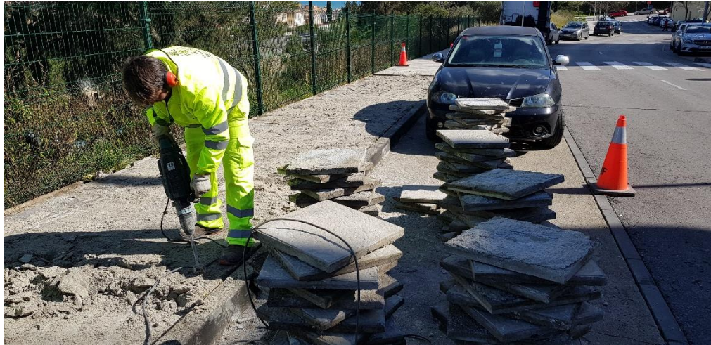
Reparación de acerado en N-357 p.k. 1
