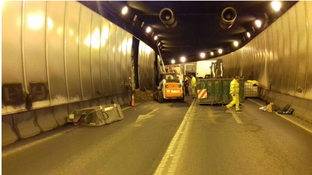
Refuerzo de intradós de pilotes en túnel N-357 p.k. 0
