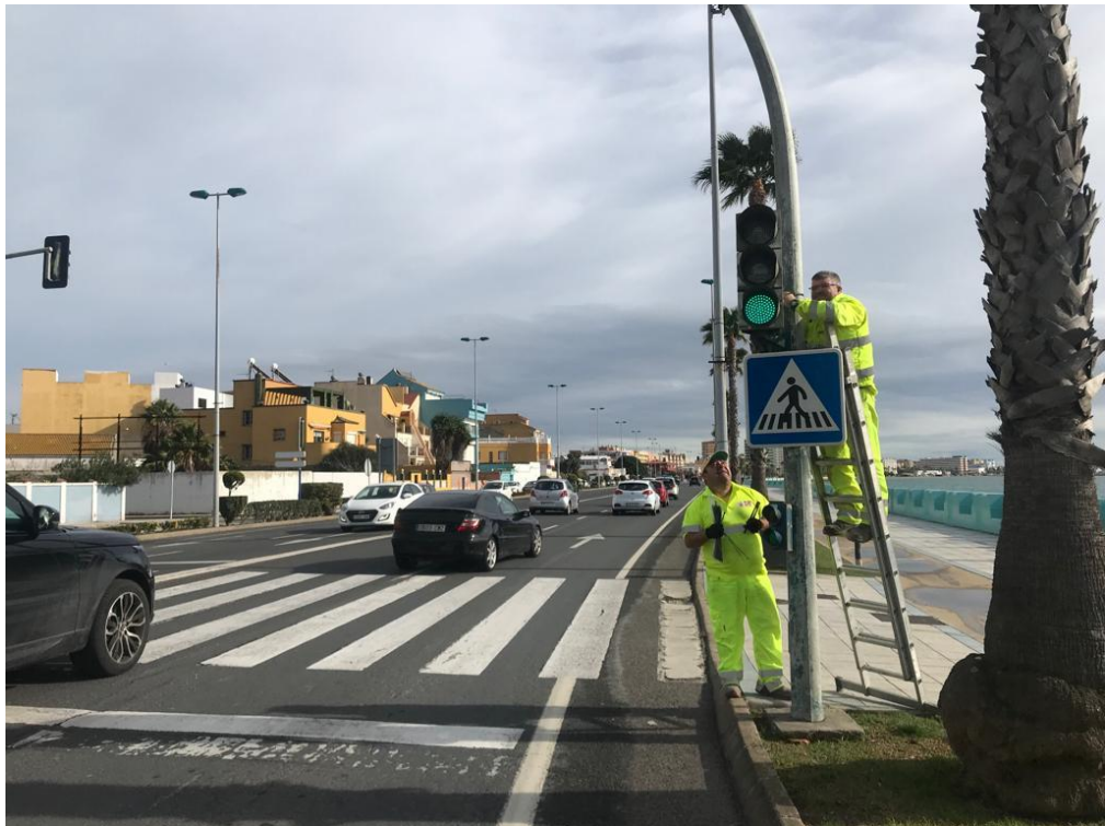
Reparación de semáforo en N-351; p.k. 5
