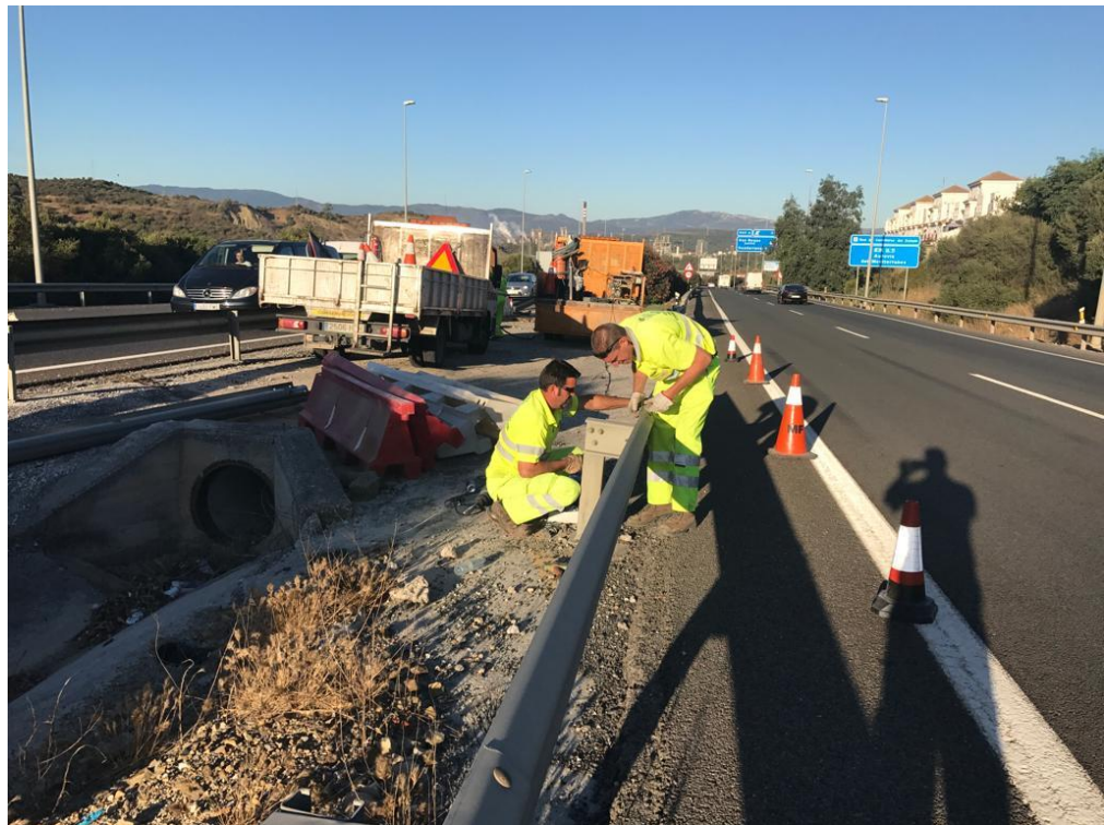
Reparación de barrera en A-7
