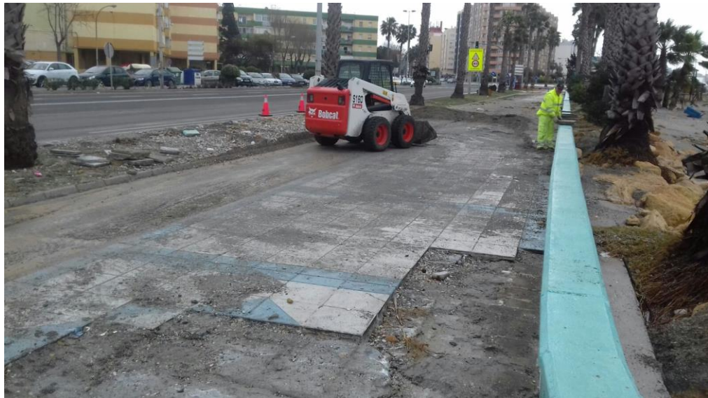
Limpieza de deterioros de temporal en la N-351 p.k. 6
