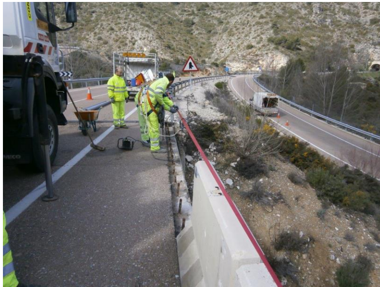
N-320 Pk 222,8 - Reparación de pretil
