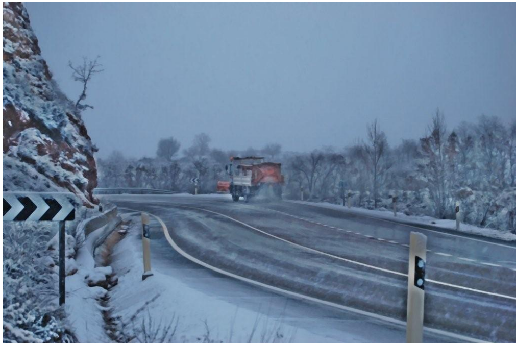
N-204 Pk 61 - Trabajos de vialidad invernal
