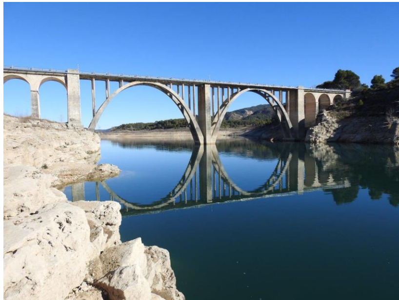
N-204 Pk 19 - Viaducto de Entrepeñas
