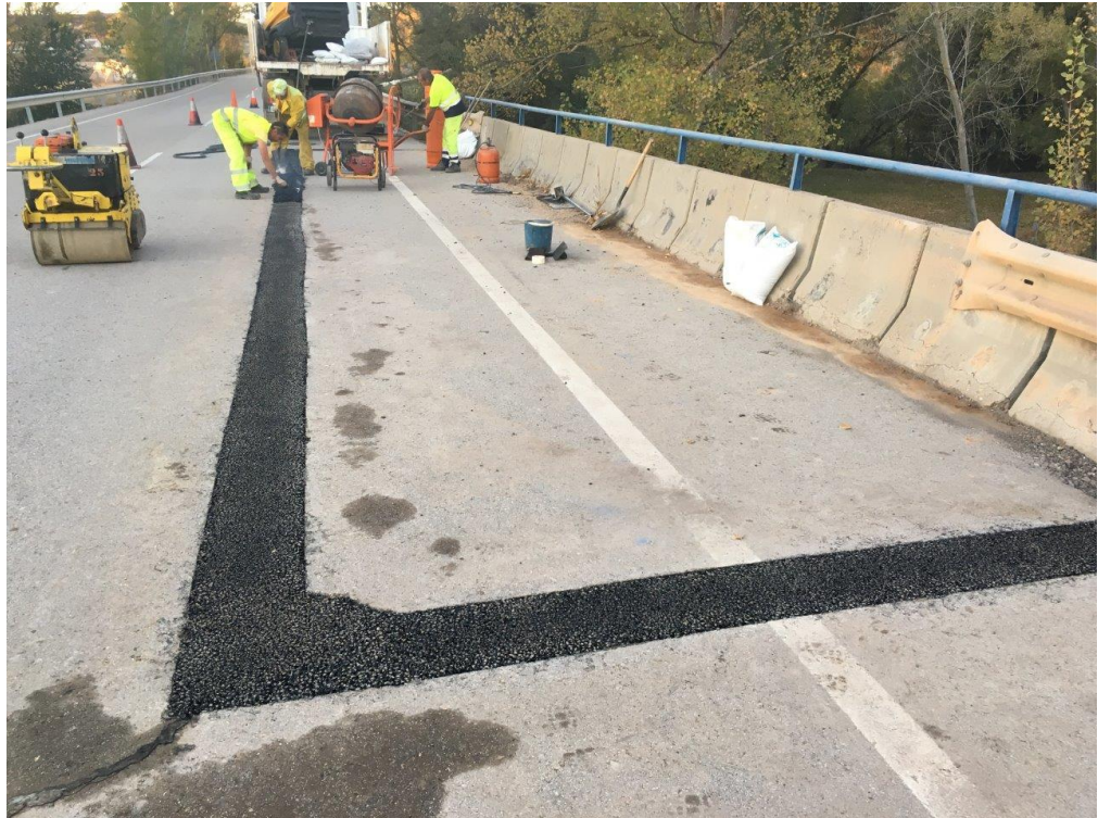
N-204 Pk 54 - Construcción de junta de dilatación
