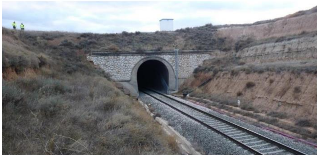
Túnel de la línea Zaragoza-Teruel-Sagunto
