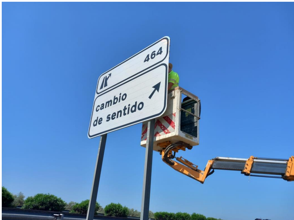
Colocación de cartel en el P.K. 464 de la A-4
