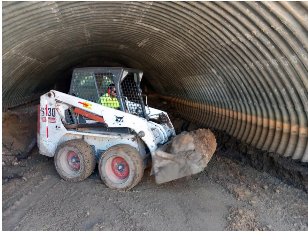
Limpieza de ODT en el P.K. 524 de la A-4
