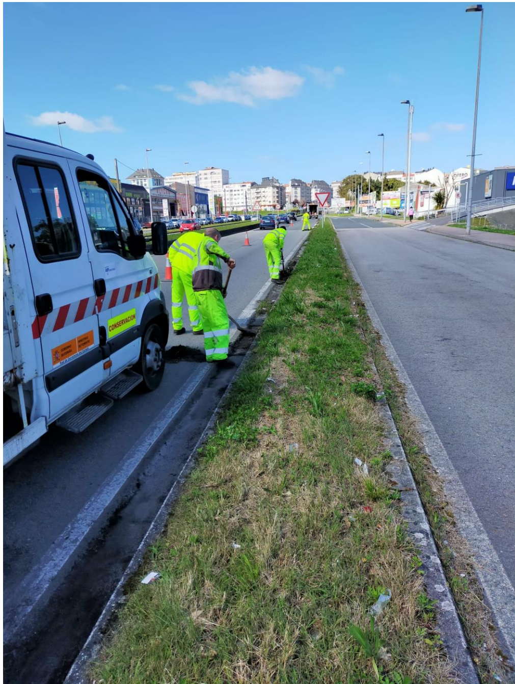
Limpieza drenaje longitudinal en la carretera FE-13
