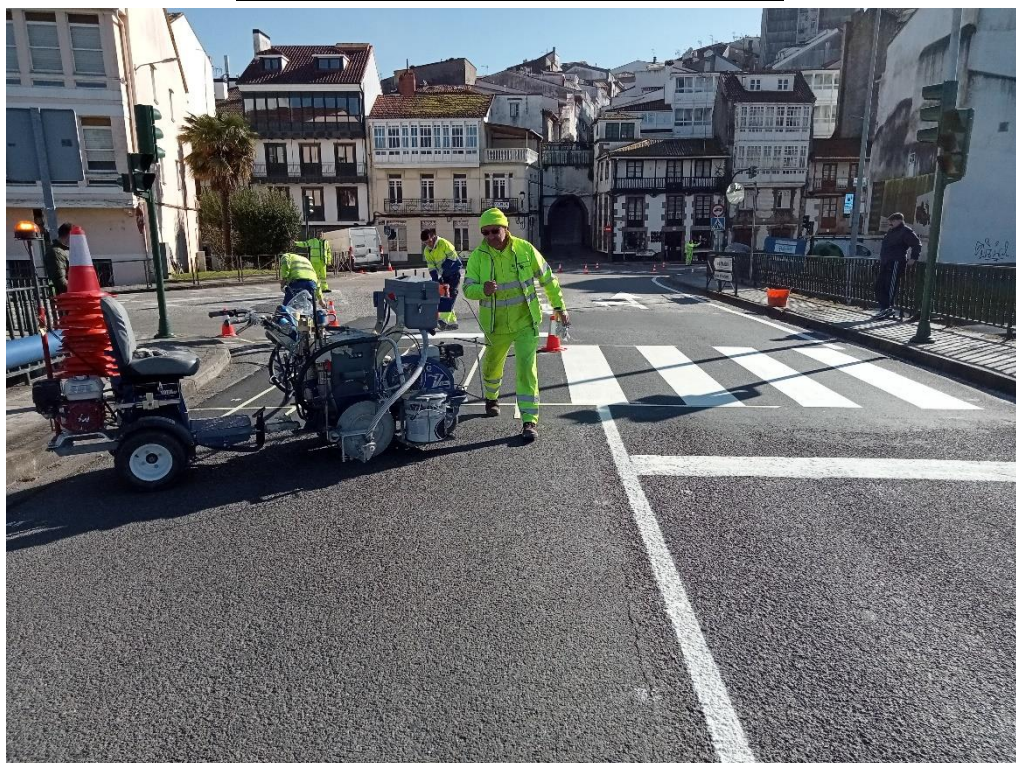
Pintado de marcas viales en la carretera N6-A
