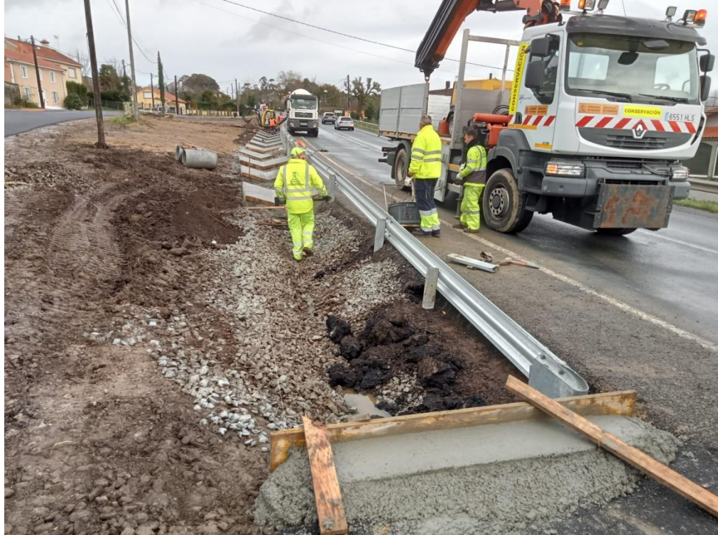
Ejecución de cunetas en la carretera N-550
