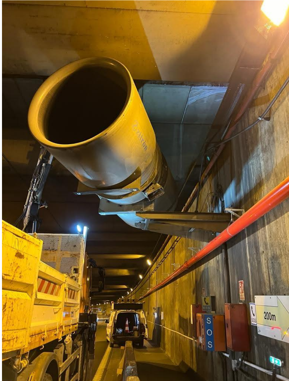
Retirada de ventilador en el túnel de Tiana, B-20
