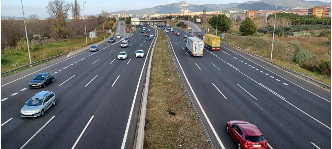
Vista general A-2, pk 606+500
