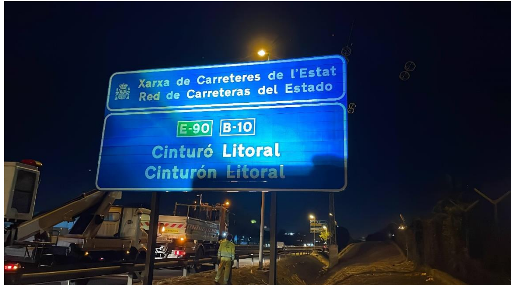
Colocación de cartel en B-10 (pk 15+800)
