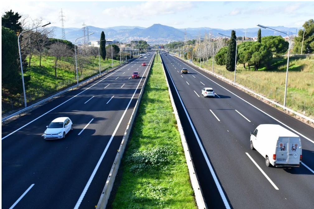
Vista general de B-23, Sant Joan Despí, pk 3+150
