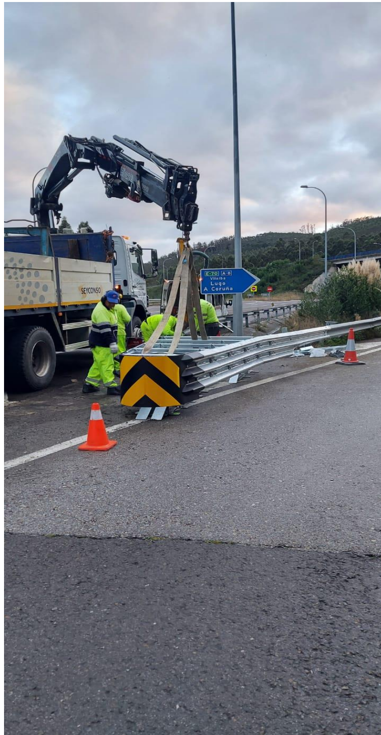
Instalación de amortiguador de impacto en enlace 516 de la A-8
