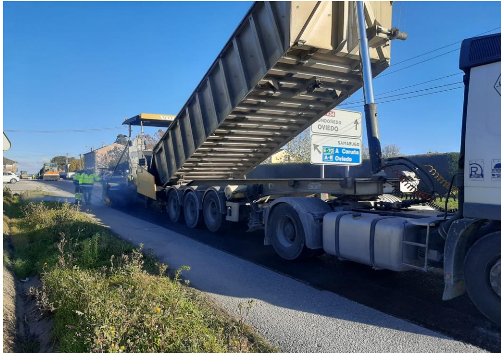
Fresado y reposición de MBC en el km 618,9 de la N-634
