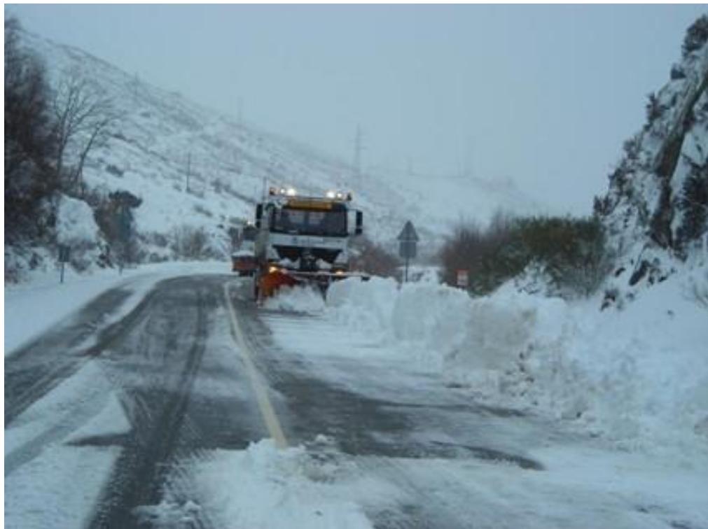
Retirada de nieve N-525 PK 116
