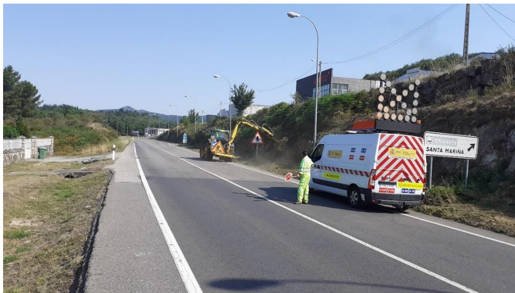
Desbroce N-525 PK 216
