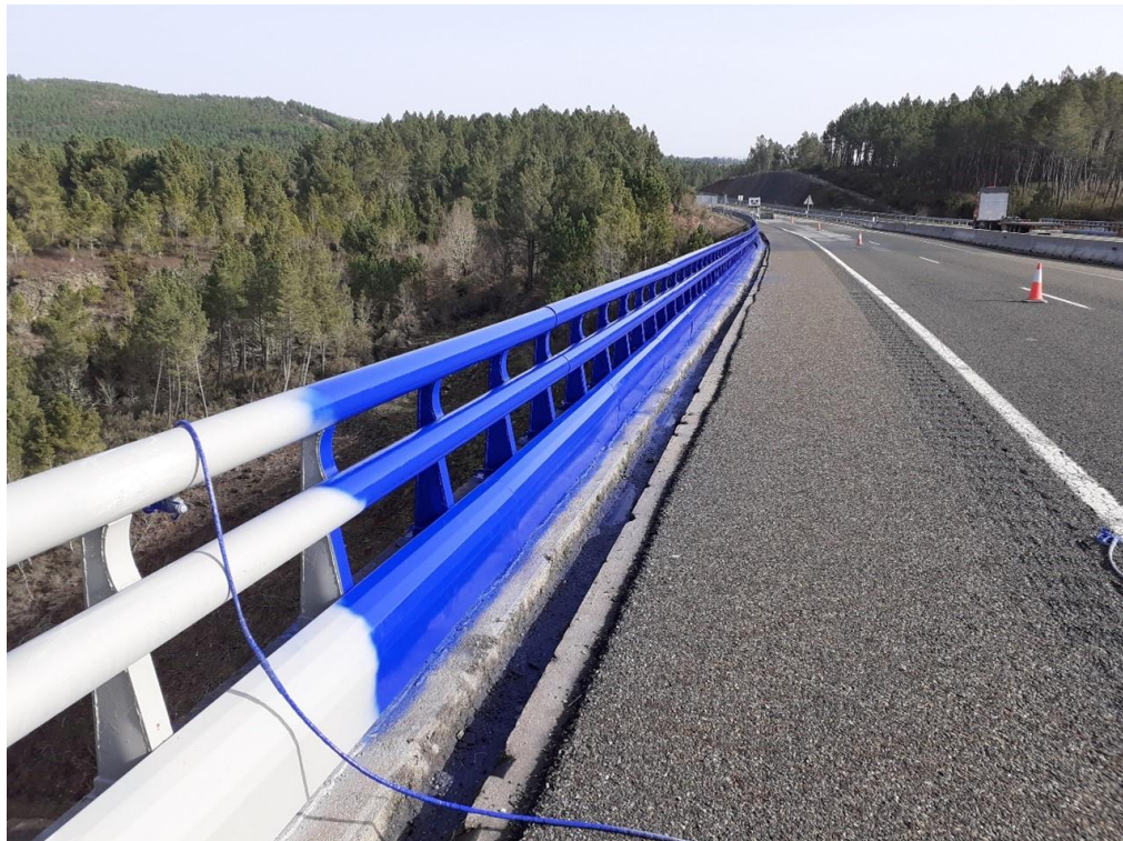
Repintado de barandilla A-525 PK 138
